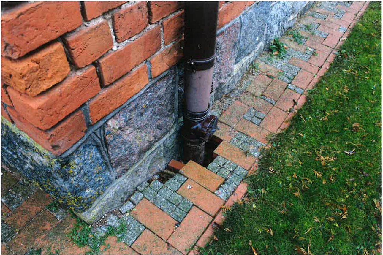
ZDJ. 17, 18 WIŚNIEWO ELCKIE. KOŚCIÓŁ P.W. M. B. GROMNICZNEJ. ELEWACJA PÓŁNOCNA. USZKODZONA OPASKA PRZY RURACH SPUSTOWYCH
