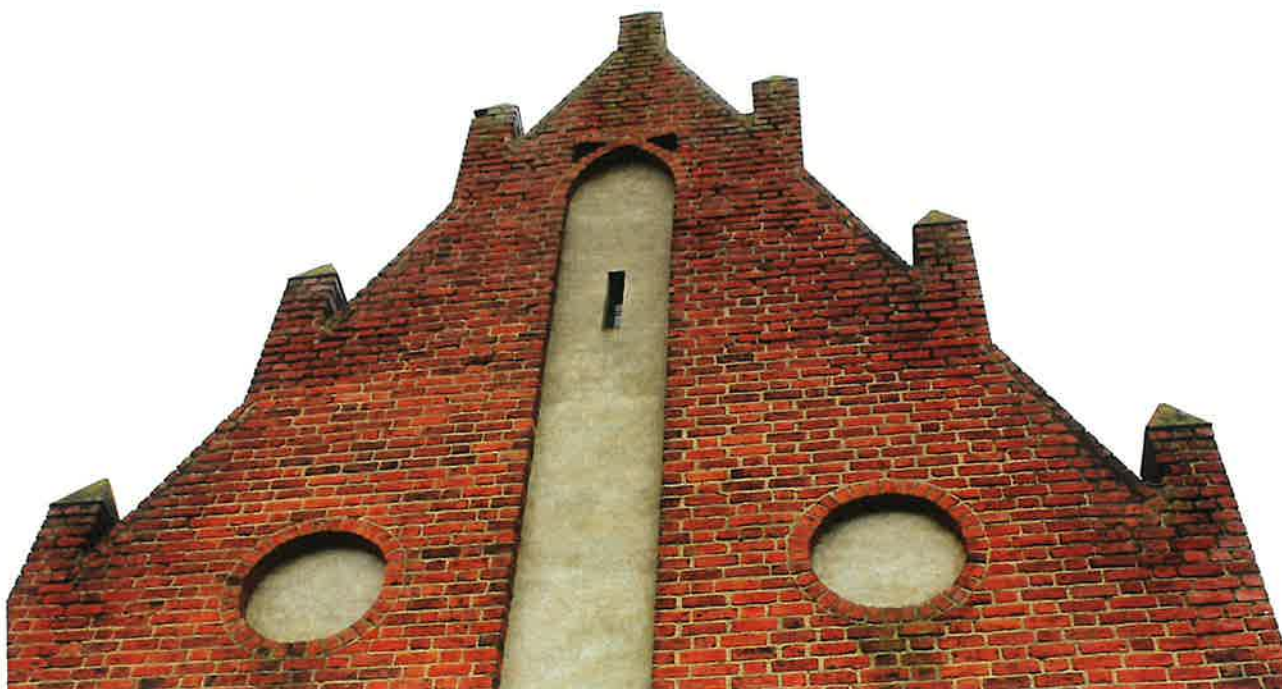
ZDJ. 13 WIŚNIEWO ELCKIE. KOŚCIÓŁ P.W. M. B. GROMNICZNEJ. SZCZYT WSCHODNI, WYPŁUKANE SPOINY BLANEK
