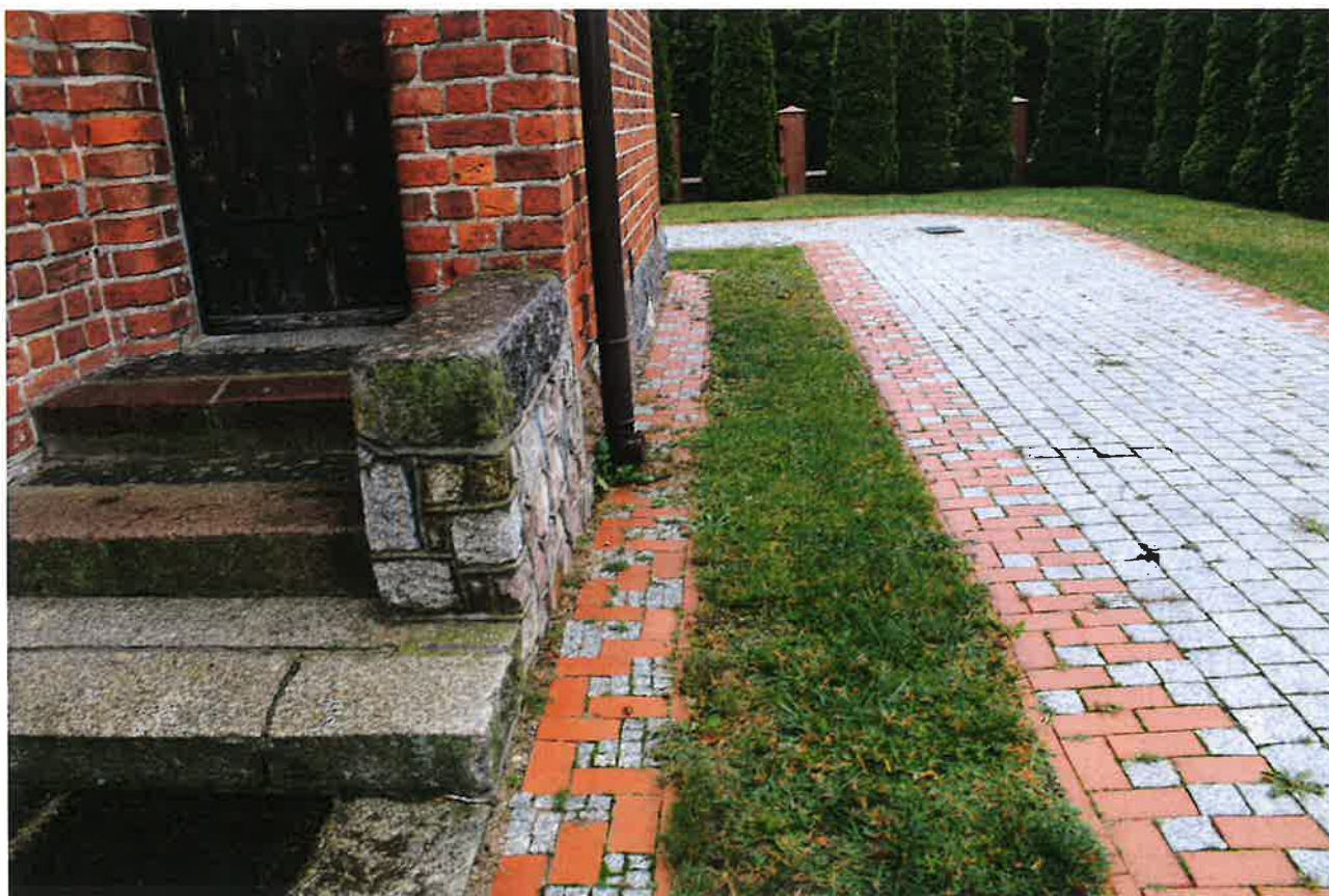
ZDJ. 20 WIŚNIEWO EŁCKIE. KOŚCIÓŁ P.W. M. B. GROMNICZNEJ. ELEWACJA POŁUDNIOWA. ZAPADNIĘTY GRUNT PRZY RURZE SPUSTOWEJ ZA WEJŚCIEM DO ZAKRYSTII
