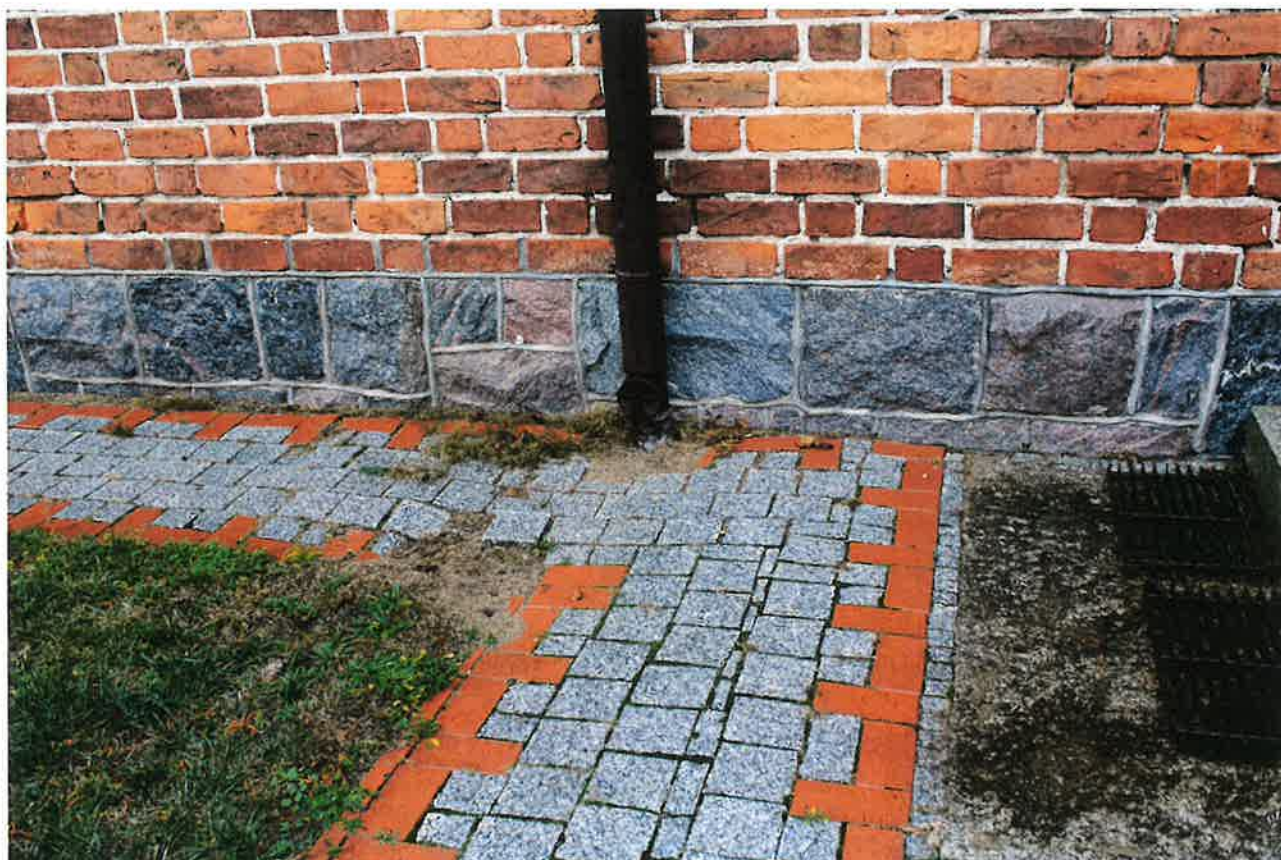
ZDJ. 19 WIŚNIEWO EŁCKIE. KOŚCIÓŁ P.W. M. B. GROMNICZNEJ. ELEWACJA POŁUDNIOWA. ZAPADNIĘTY GRUNT PRZY RURZE SPUSTOWEJ PRZED WEJŚCIEM DO ZAKRYSTII
