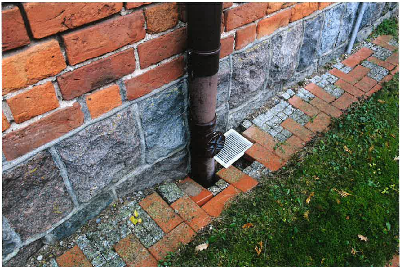
ZDJ. 17, 18 WIŚNIEWO ELCKIE. KOŚCIÓŁ P.W. M. B. GROMNICZNEJ. ELEWACJA PÓŁNOCNA. USZKODZONA OPASKA PRZY RURACH SPUSTOWYCH
