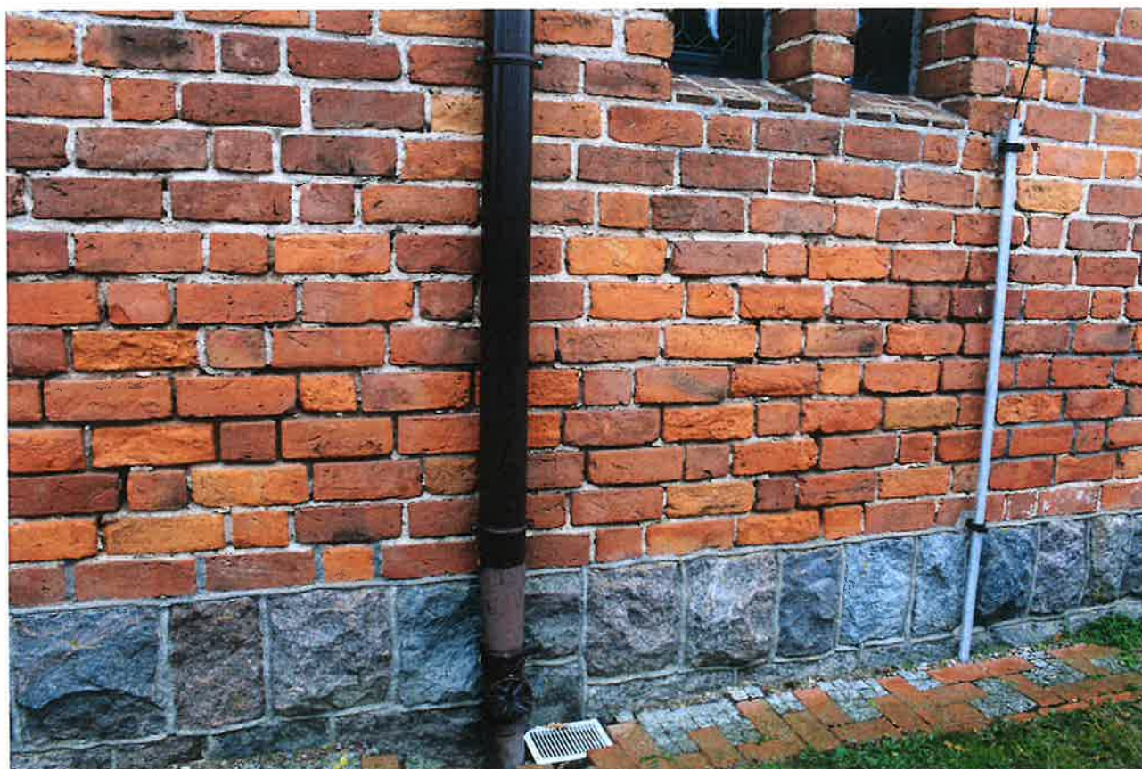
ZDJ. 6 WIŚNIEWO ELCKIE. KOŚCIÓŁ P.W. M. B. GROMNICZNEJ. ELEWACJA POŁUDNIOWA . WIDOCZNE CEGŁY „NIEDOPAŁKI” I WYPŁUKANE SPOINY
