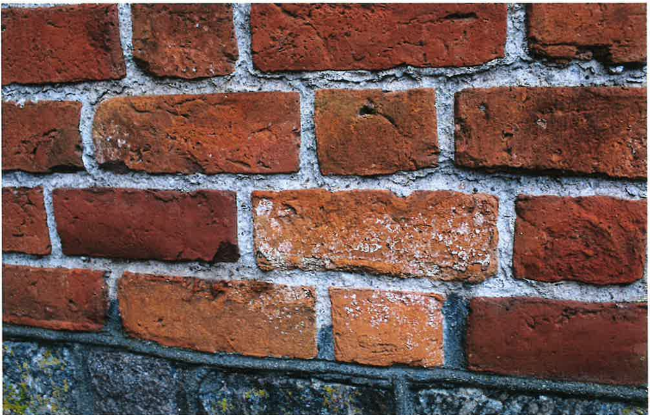
ZDJ. 8 WIŚNIEWO EŁCKIE. KOŚCIÓŁ P.W. M. B. GROMNICZNEJ. ELEWACJA ZACHODNIA . WYSOLENIA NA POWIERZCHNI CEGIEŁ
