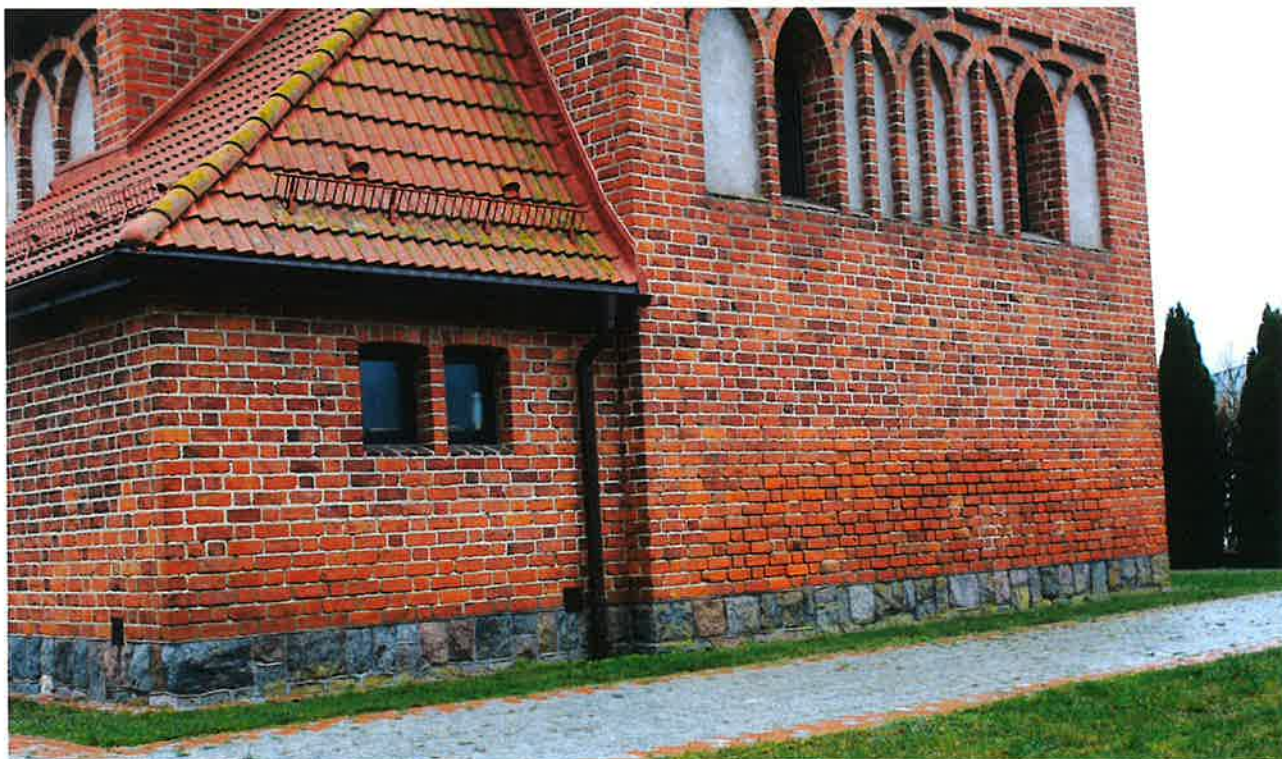
ZDJ. 15 WIŚNIEWO EŁCKIE. KOŚCIÓŁ P.W. M. B. GROMNICZNEJ. ELEWACJA WSCHODNIA. ZAWILGOCENIA
