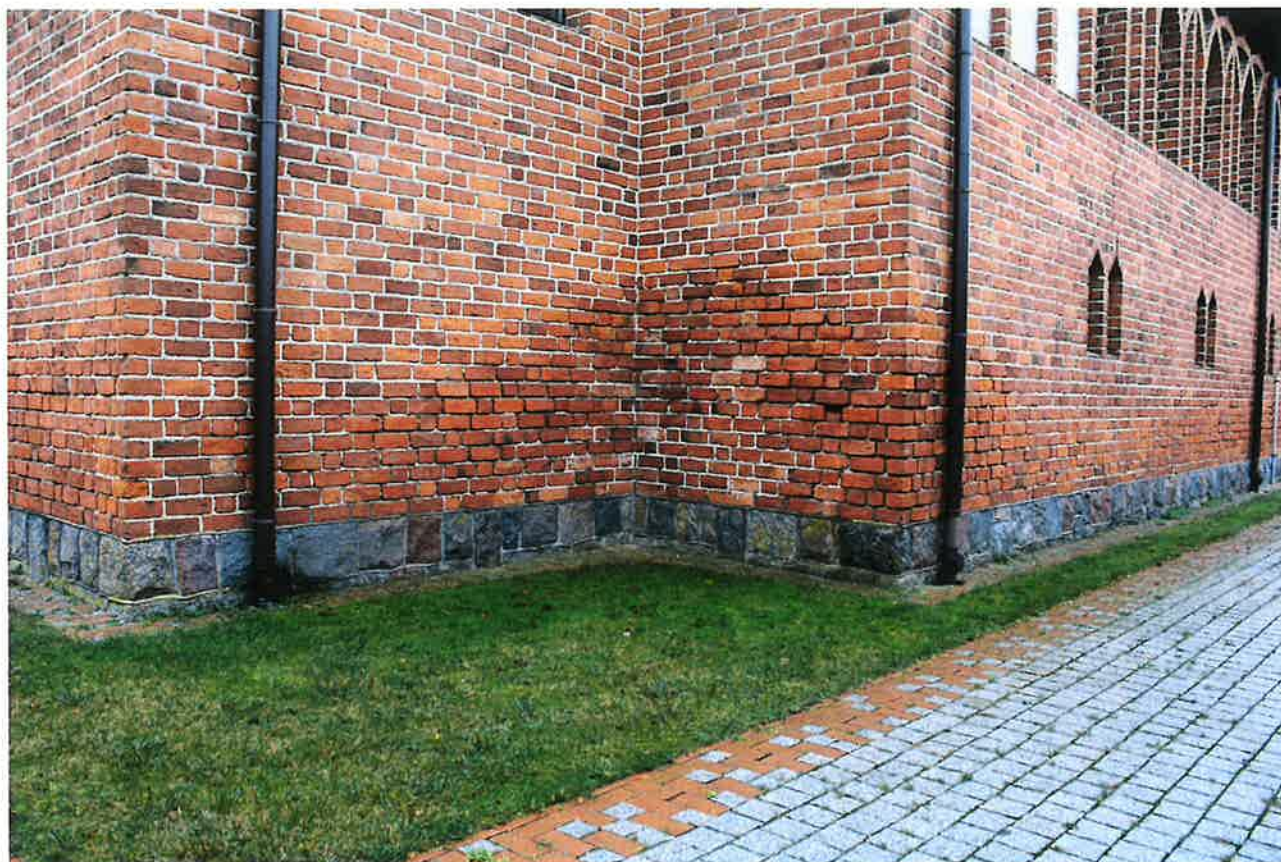
ZDJ. 16 WIŚNIEWO ELCKIE. KOŚCIÓŁ P.W. M. B. GROMNICZNEJ. ELEWACJA WSCHODNIA. ZAWILGOCENIA
