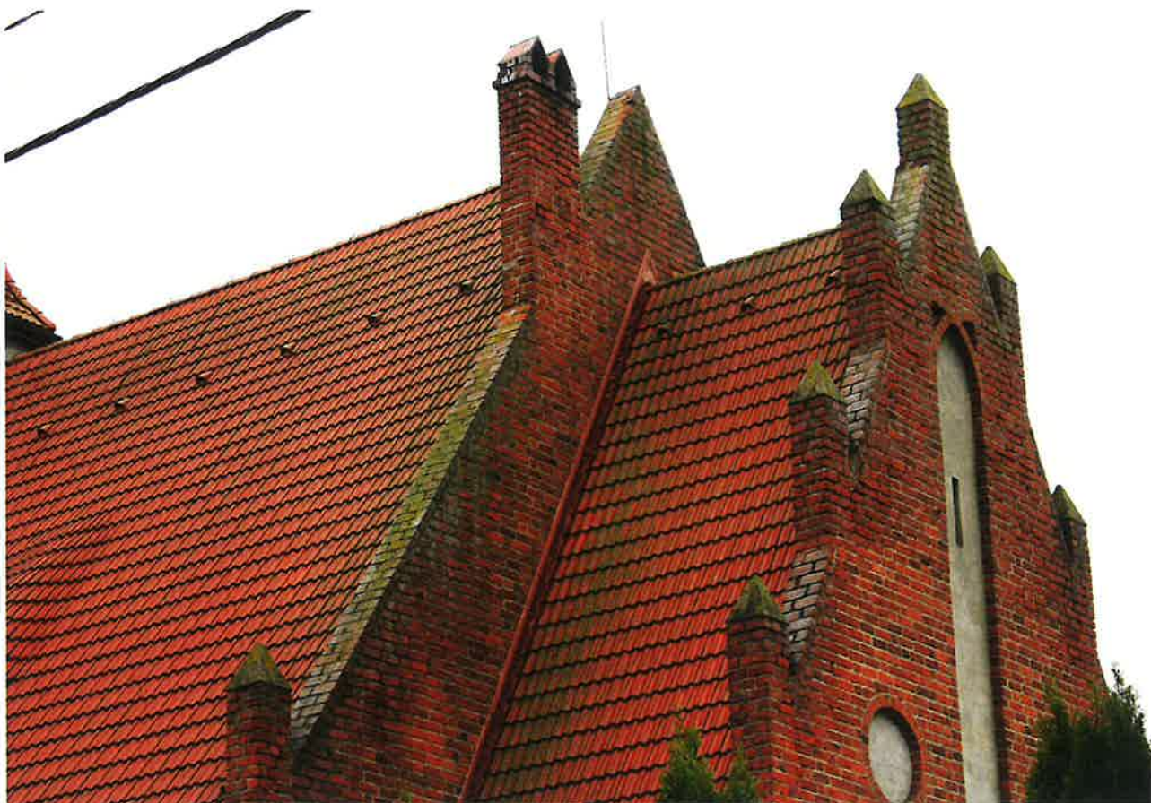
ZDJ. 10 WIŚNIEWO EŁCKIE. KOŚCIÓŁ P.W. M. B. GROMNICZNEJ. SZCZYT WSCHODNI, ZIELONO ŻÓŁTE ZABRUDZENIA POCHODZENIA BIOLOGICZNEGO
