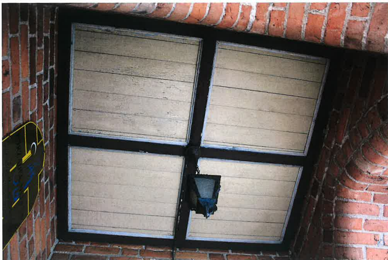
ZDJ. 23 WIŚNIEWO EŁCKIE. KOŚCIÓŁ P.W. M. B. GROMNICZNEJ. DREWNIANY STROP PODCIENIA WEJŚCIOWEGO
