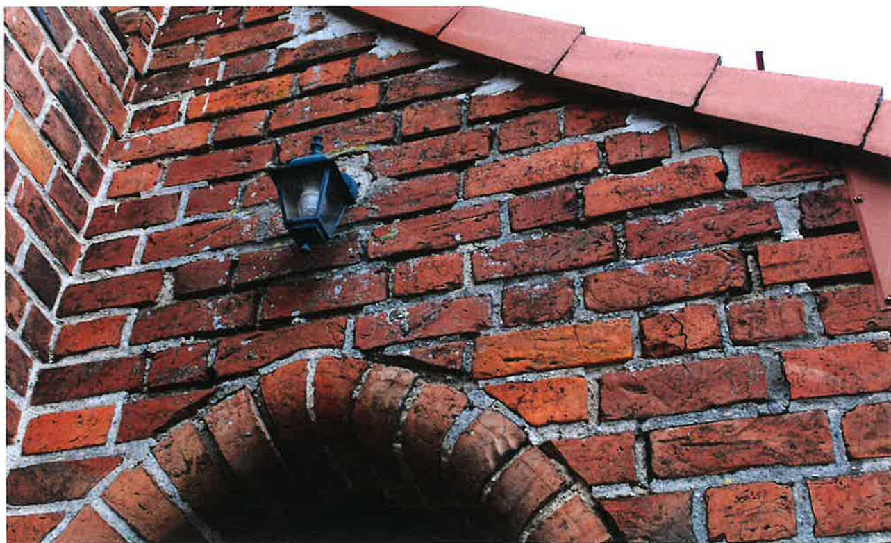
ZDJ. 11 WIŚNIEWO EŁCKIE. KOŚCIÓŁ P.W. M. B. GROMNICZNEJ. WEJŚCIE DO ZAKRYSTII. WIDOCZNE NIESTARANNE, WTÓRNE NAPRAWY SPOIN, ROZŁUŻNIENIE SPOISTOŚCI MURU, WYSUNECIE KSZTAŁTKI NADPROŻA DRZWIOWEGO
