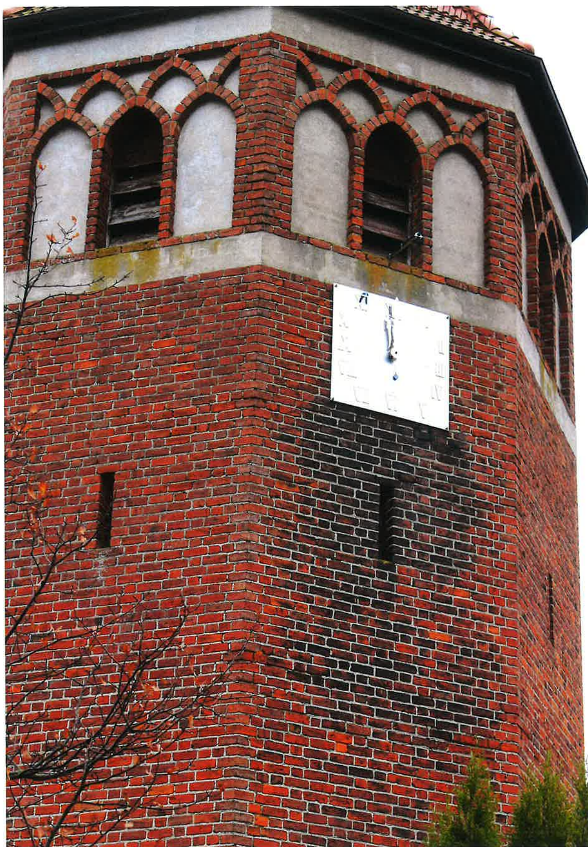
ZDJ. 9 WIŚNIEWO EŁCKIE. KOŚCIÓŁ P.W. M. B. GROMNICZNEJ. WIEŻA . CIEMNE ZABRUDZENIA SPowodowane METALOWYMI KOTWAMI ZEGARA, ZIELONO ŻÓŁTE ZABRUDZENIA POCHODZENIA BIOLOGICZNEGO
