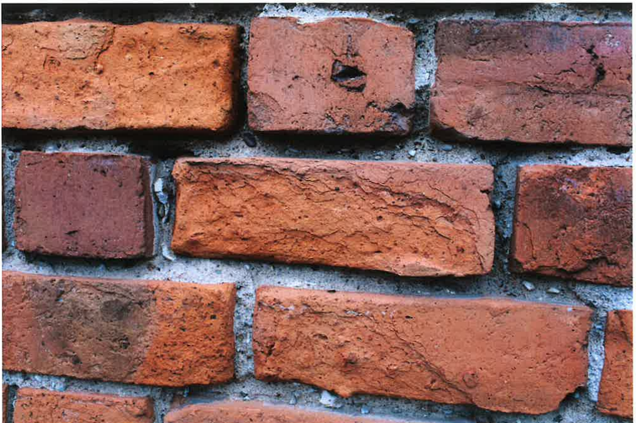
ZDJ. 7 WIŚNIEWO EŁCKIE. KOŚCIÓŁ P.W. M. B. GROMNICZNEJ. ELEWACJA ZACHODNIA . DESTRUKCJA CEGIEŁ
