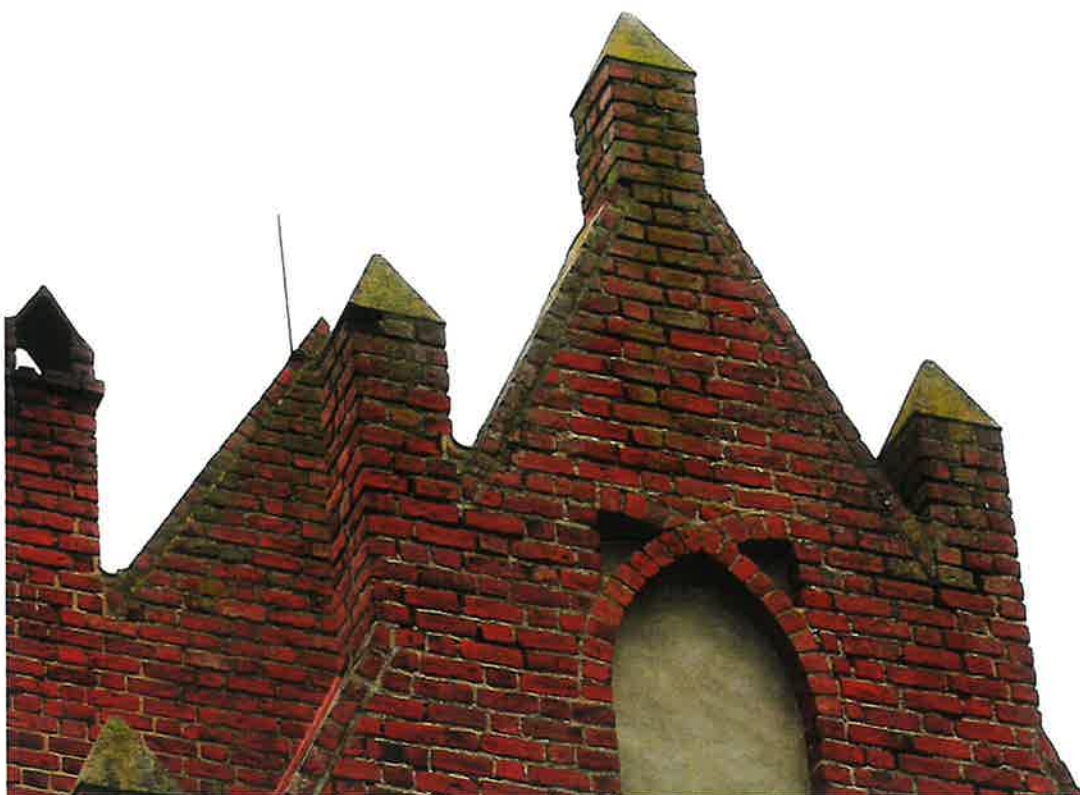
ZDJ. 12 WIŚNIEWO ELCKIE. KOŚCIÓŁ P.W. M. B. GROMNICZNEJ. SZCZYT WSCHODNI, ZIELONO ŻÓŁTE ZABRUDZENIA POCHODZENIA BIOLOGICZNEGO, WYPŁUKANE SPOINY BLANEK
