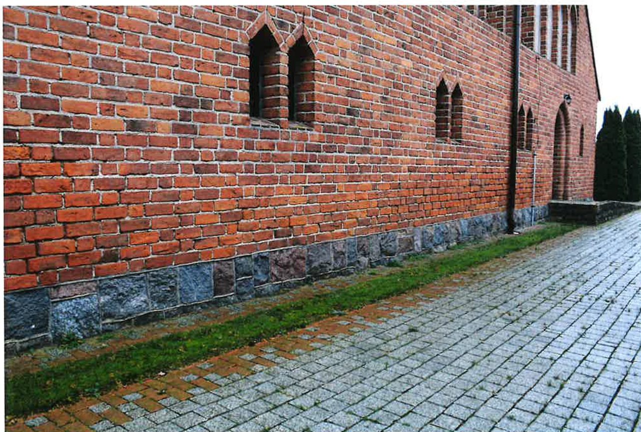
ZDJ. 16 WIŚNIEWO ELCKIE. KOŚCIÓŁ P.W. M. B. GROMNICZNEJ. ELEWACJA WSCHODNIA. ZAWILGOCENIA
