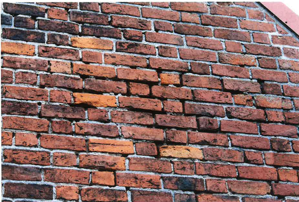
ZDJ. 5 WIŚNIEWO ELCKIE. KOŚCIÓŁ P.W. M. B. GROMNICZNEJ. ELEWACJA ZACHODNIA . WIDOCZNE CEGŁY „NIEDOPAŁKI” I WYPŁUKANE SPOINY
