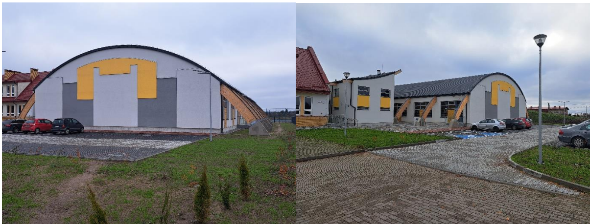
Budowa hali sportowej w Prostkach
