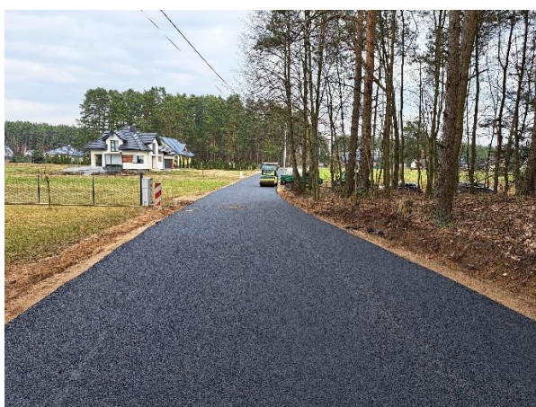
Przebudowa drogi ul. Bojowników w Boguszech.
