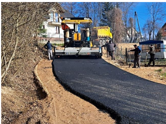
Przebudowa drogi w miejscowości Kurzątki.
