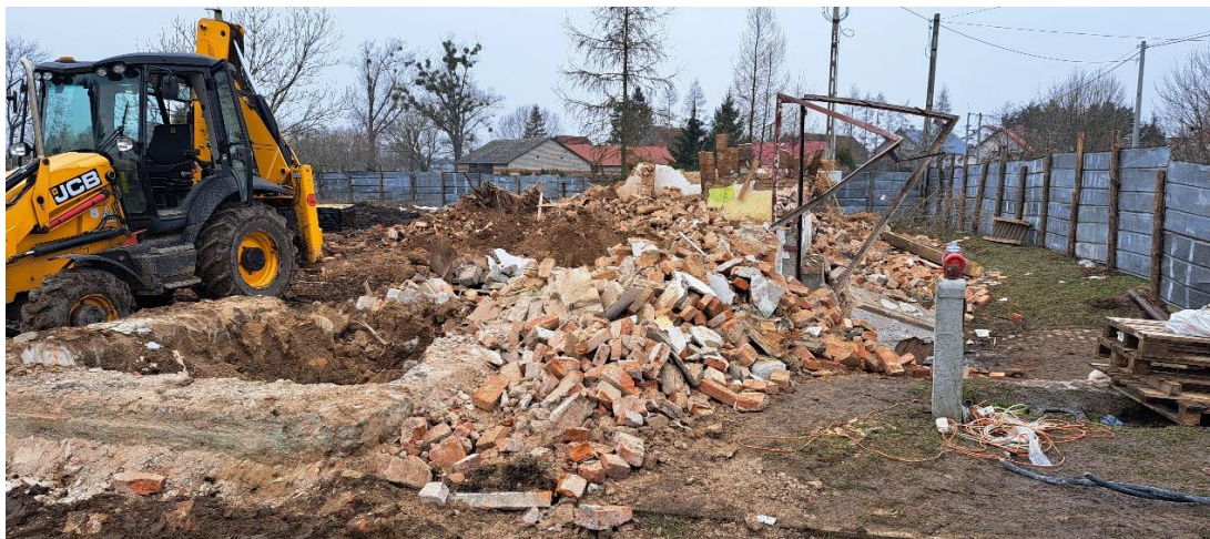
Rozbórka starej remizy OSP w Wiśniowie Ełckim
