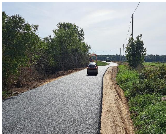
Przebudowa drogi w miejscowości Kopijki.
