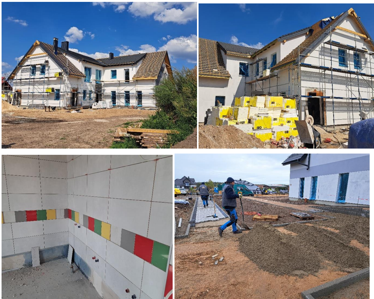
Budowa przedszkola w Prostkach
