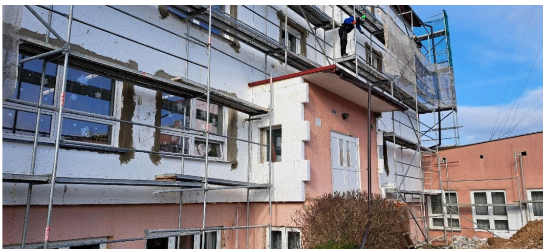
Rozpoczęcie robót termomodernizacyjnych w Szkole w Wiśniowie Ełckim
