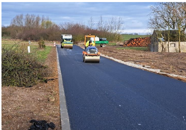
Przebudowa drogi w miejscowości Kobylin.
