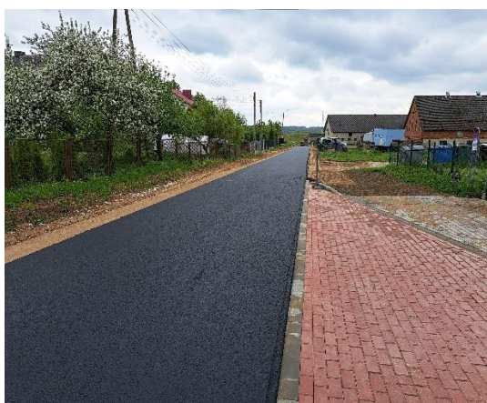
Przebudowa drogi w miejscowości Borki.
