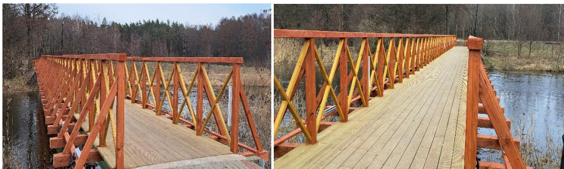
Remont kładki pieszej na rzece Elk
