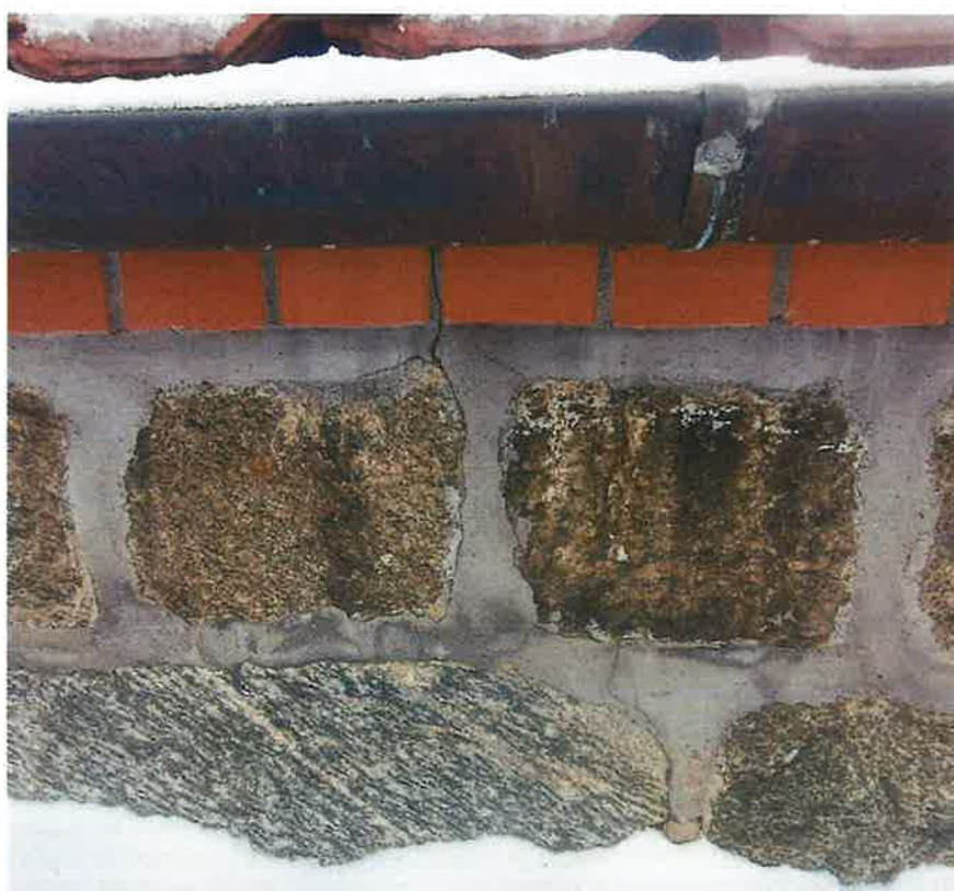
Fot.15. Spękania cokołu
