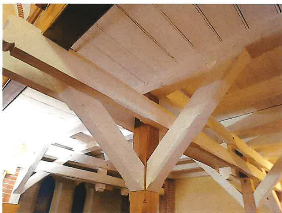
Fot.7 i 8. Widok na filary, krokwiny i deskowany strop chóru.
