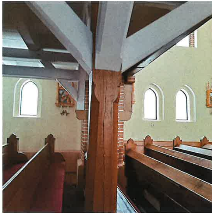
Fot.9. Podłużne spękanie na filarze
