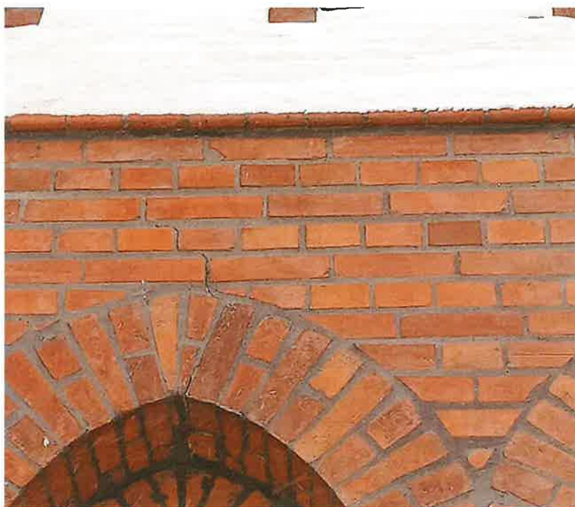
Fot.5. Spękanie nad i na łuku otworu okiennego elewacji południowej
