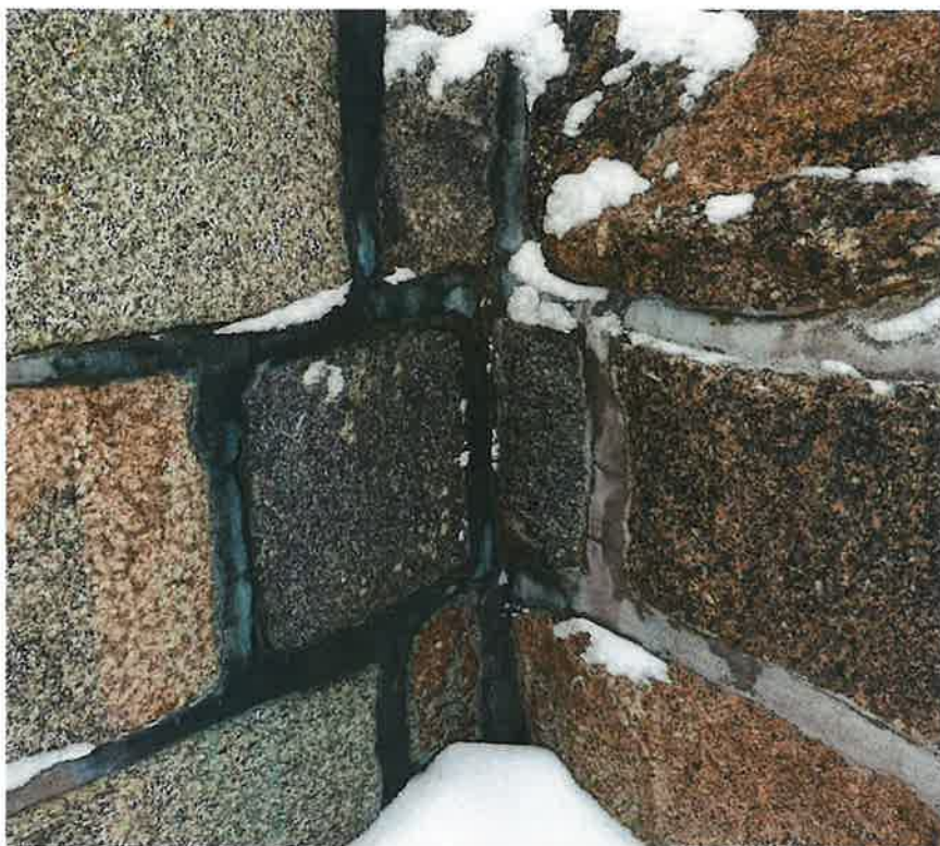
Fot.14. Mocne zawilgocenia i korozja mikrobiologiczna na wtórnej cementowej fudze cokołu
