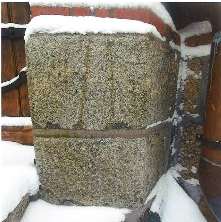
Fot.12. Spękania, zawilgocenia i korozja mikrobiologiczna na cokole kościoła
