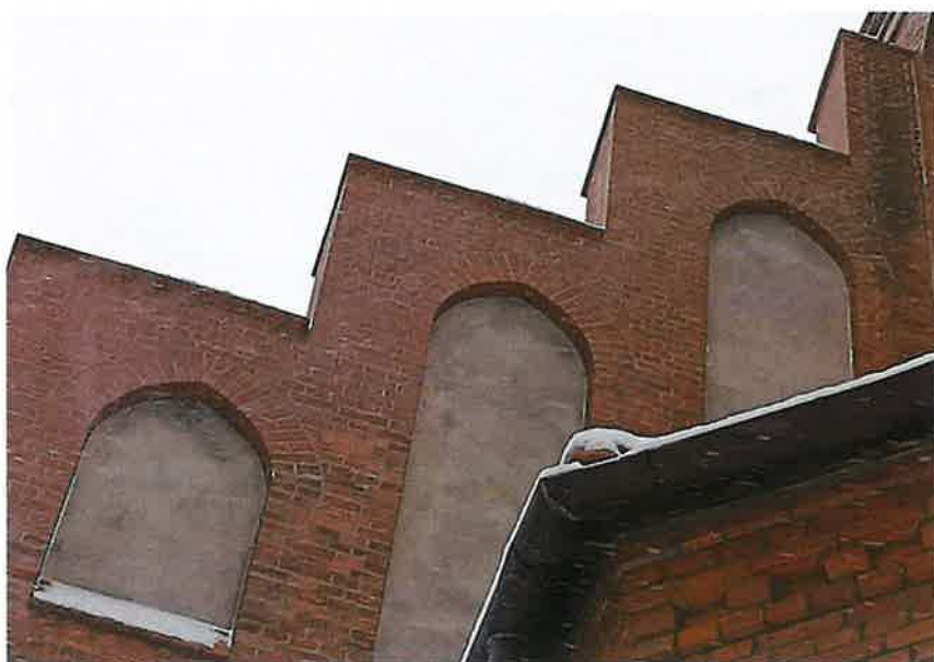
Fot. 8 i 9. Zawilgocenia i odspojenia tynku na błdach wschodniego schodkowego szczytu kościoła
