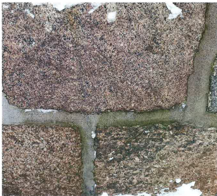
Fot.13. Zawilgocenia i wykwity korozji mikrobiologicznej na wtórej cementowej fudze cokołu
