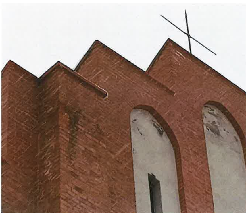
Fot.10 i 11. Zawilgocenia, spękania i odspojenia tynku na błdach wschodniego schodkowego szczytu, a także zawilgocenia na ścianie szczytowej
