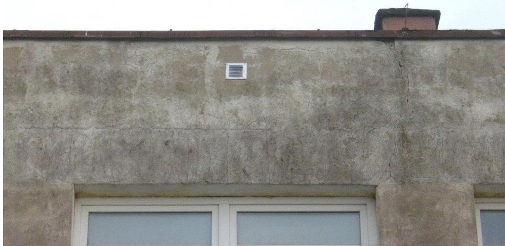
Foto.23. Stalowa kratka zabezpieczająca wszystkie otwory wentylacyjne stropodachu; fot. Przemysław Kubacki.
