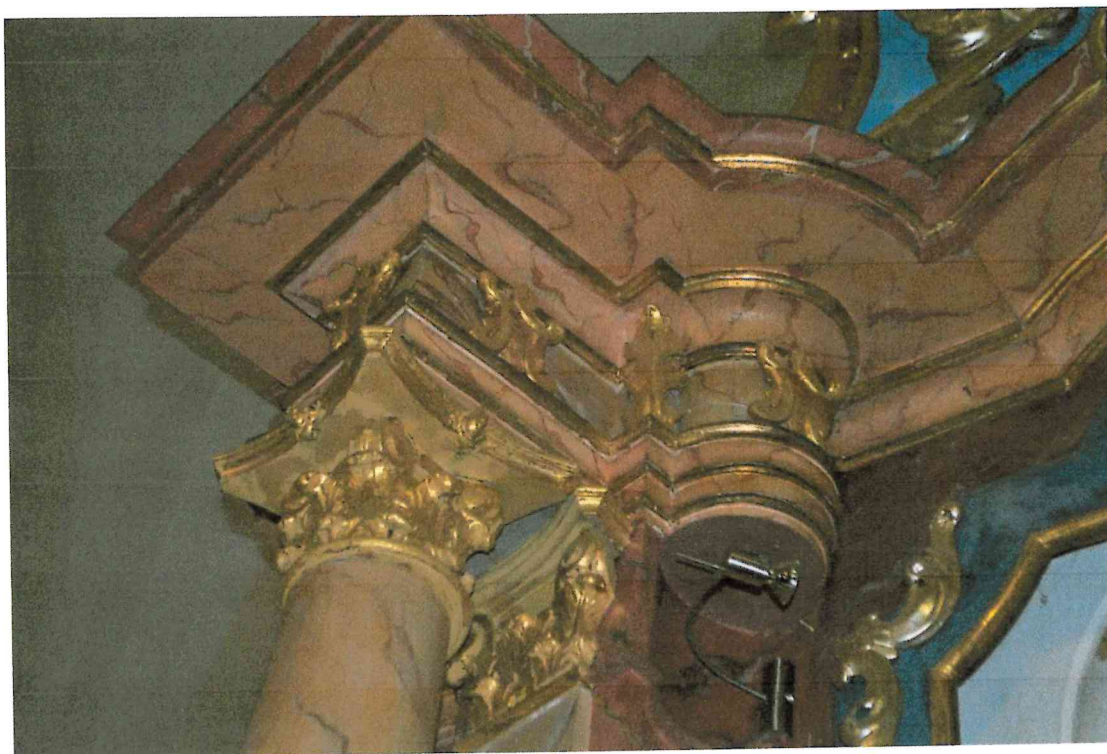
Fot. 12. Ołtarz główny przed konserwacją, fragment. Widoczne zamontowane oświetlenie.
