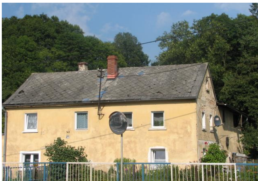
Fot. 4. Dach budynku mieszkalnego pokryty płytami płaskimi typu „karo” (ul. Chrobrego)
