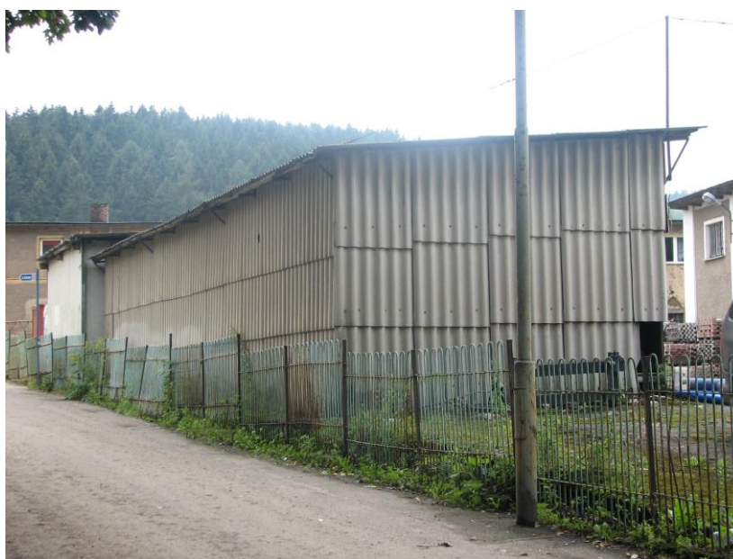
Fot. 5. Hala pokryta płytami azbestowymi na terenie Rozlewni Wód Mineralnych (2010r).
