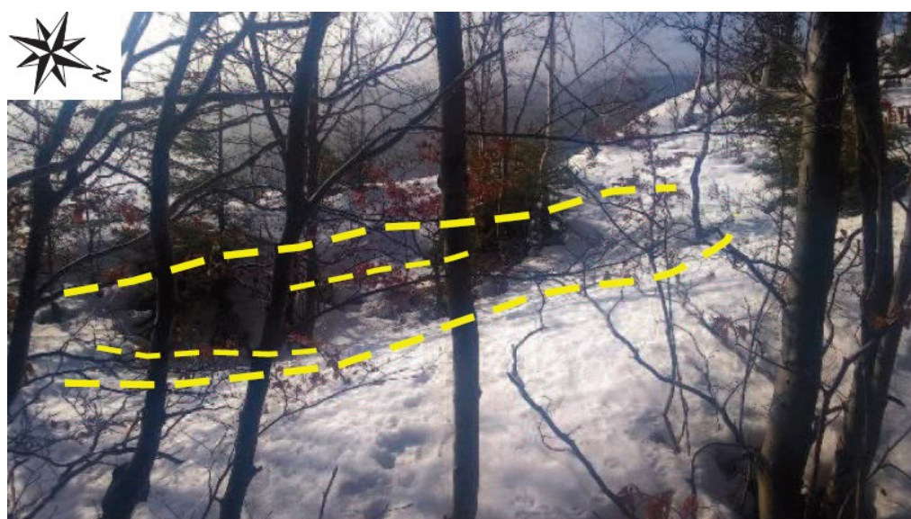
Fotografia 19. Deformacje powierzchni oraz szczeliny z rozciągania (fot. Lhoist S.A., 01.2019r.)
