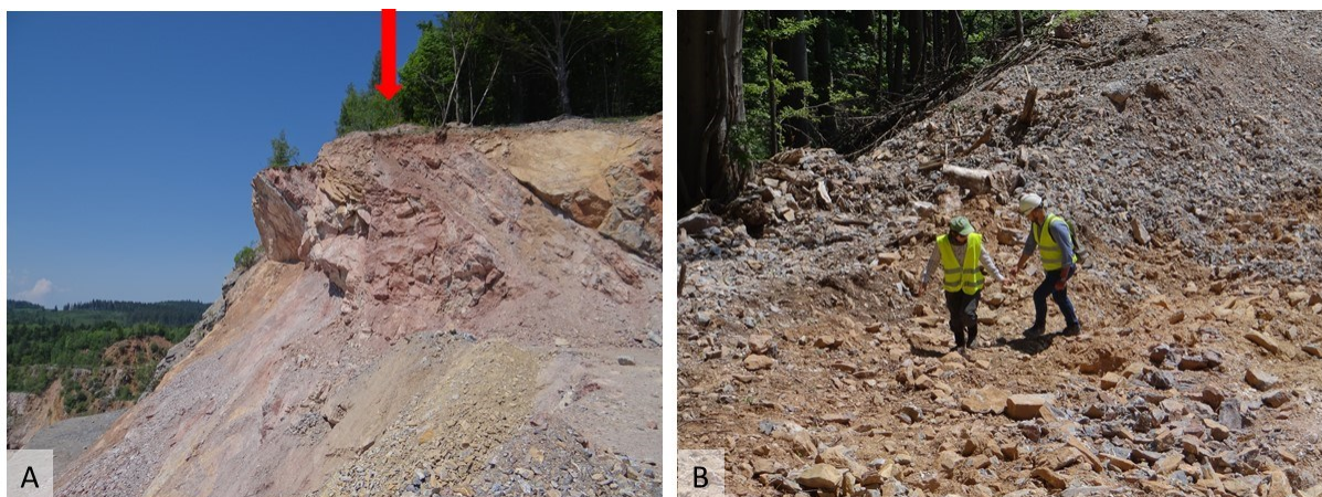
Fotografia 20. Okazanie na gruncie nadzorowi przyrodniczemu powstałego zagrożenia we wschodniej części odkrywki; A – wskazane czerwoną strzałką miejsce planowanego odstrzału widocznego nawisu skalnego, B – wizja terenowa specjalisty ds. geologii – Jerzego Wójtowicza oraz dr Anny Wójcickiej-Rosińskiej (04.06.2019 r.)
