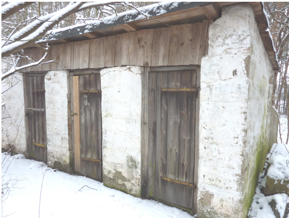
Fot. 11 Część elewacji południowo-wschodniej i północno-wschodniej budynku gospodarczego oznaczonego lit. "G"
