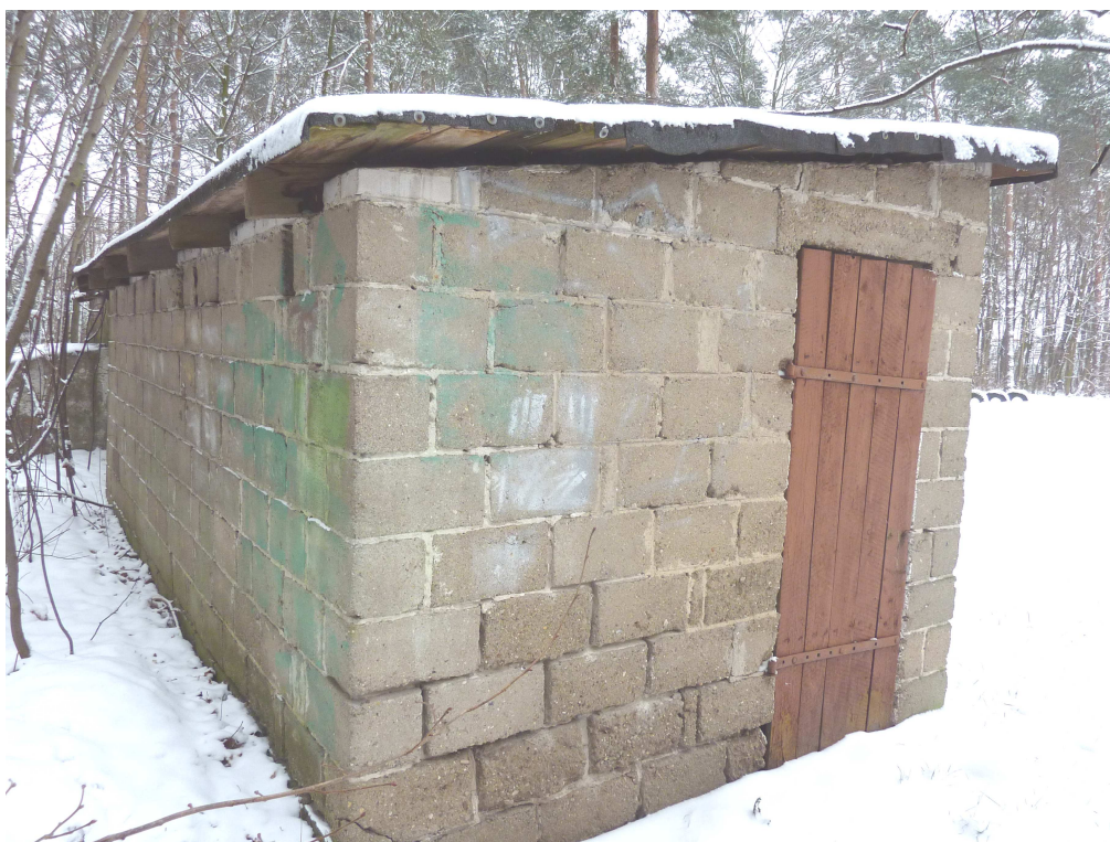
Fot. 10 Elewacja południowo-zachodnia i północno-zachodnia budynku gospodarczego oznaczonego lit. "G"
