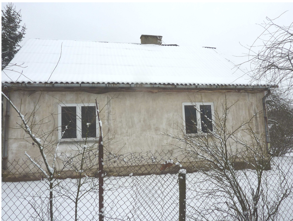
Fot. 1 Elewacja północno - zachodnia budynku mieszkalnego
