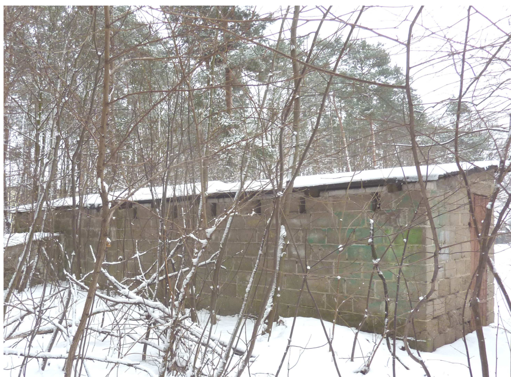
Fot. 12 Elewacja północno-zachodnia budynku gospodarczego oznaczonego lit. "G"
