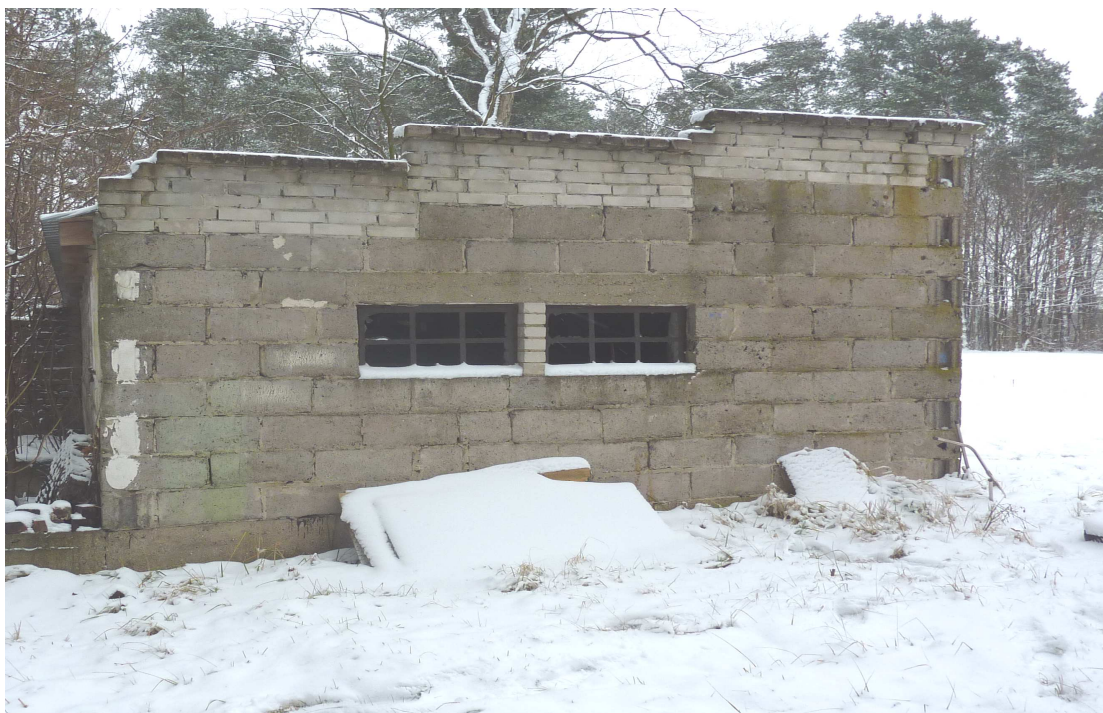
Fot.7 Elewacja południowo-zachodnia budynku gospodarczego oznaczonego lit. "F"
