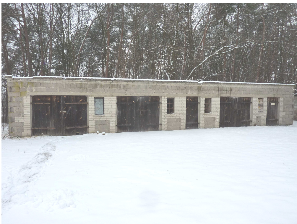
Fot. 5 Elewacja południowo-wschodnia budynku gospodarczego oznaczonego lit. "F"
