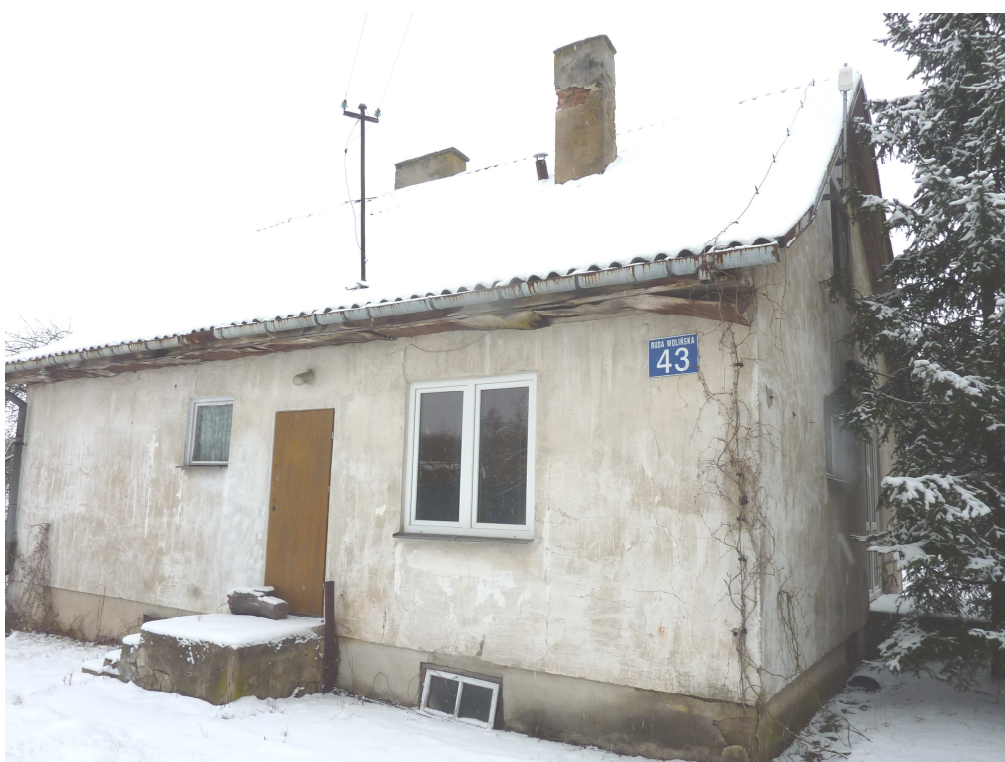
Fot. 4 Elewacja południowo-wschodnia oraz część elewacji północno-wschodniej budynku mieszkalnego
