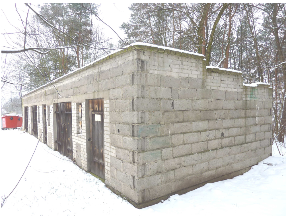
Fot. 6 Elewacja południowo - wschodnia i północno-wschodnia budynku gospodarczego oznaczonego lit. "F"
