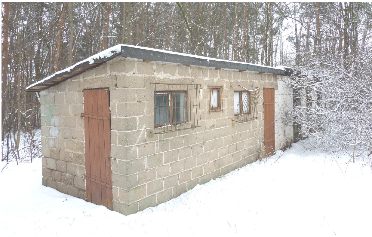
Fot. 9 Elewacja południowo-zachodnia i południowo-wschodnia budynku gospodarczego oznaczonego lit. "G"
