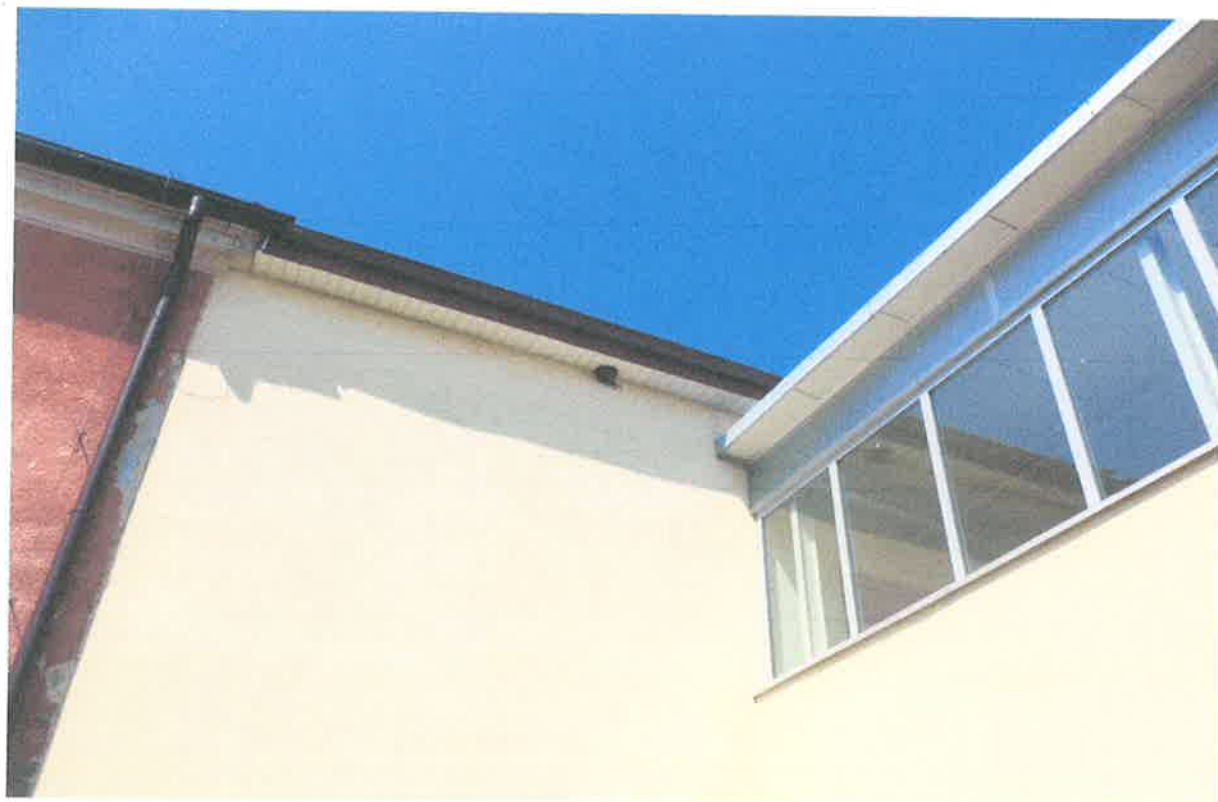
Gniazdo oknówki nr 4 przy łączniku
