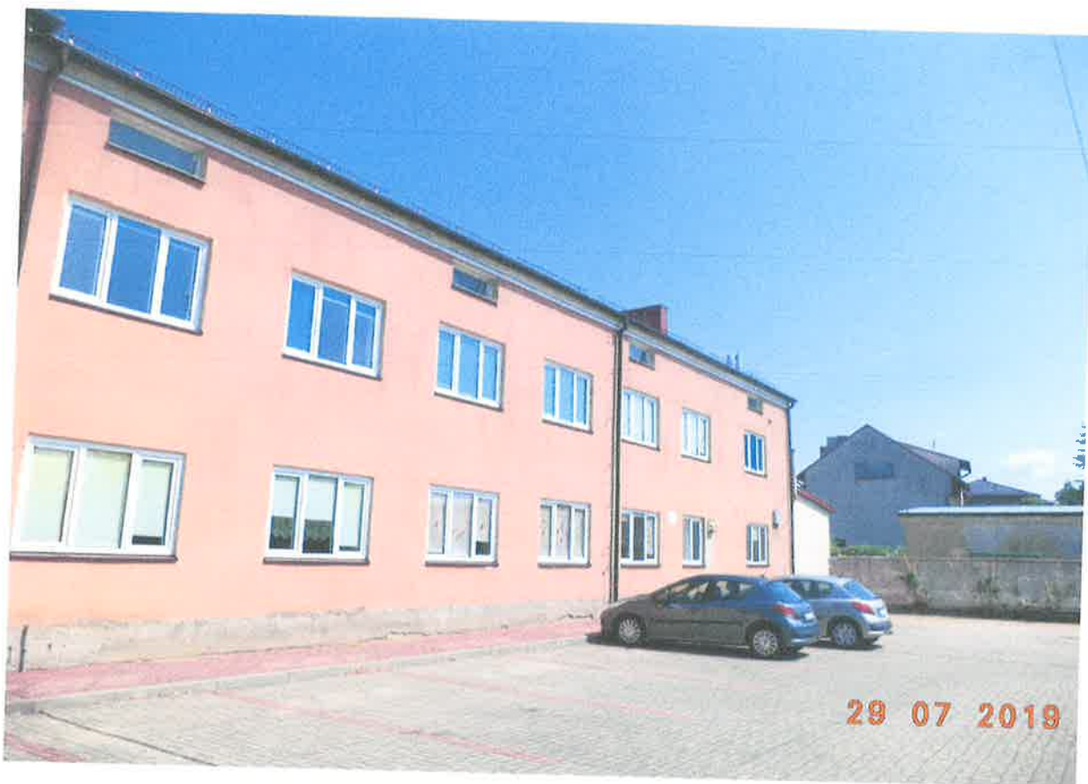
Budynek główny od strony ul. Szkolnej
