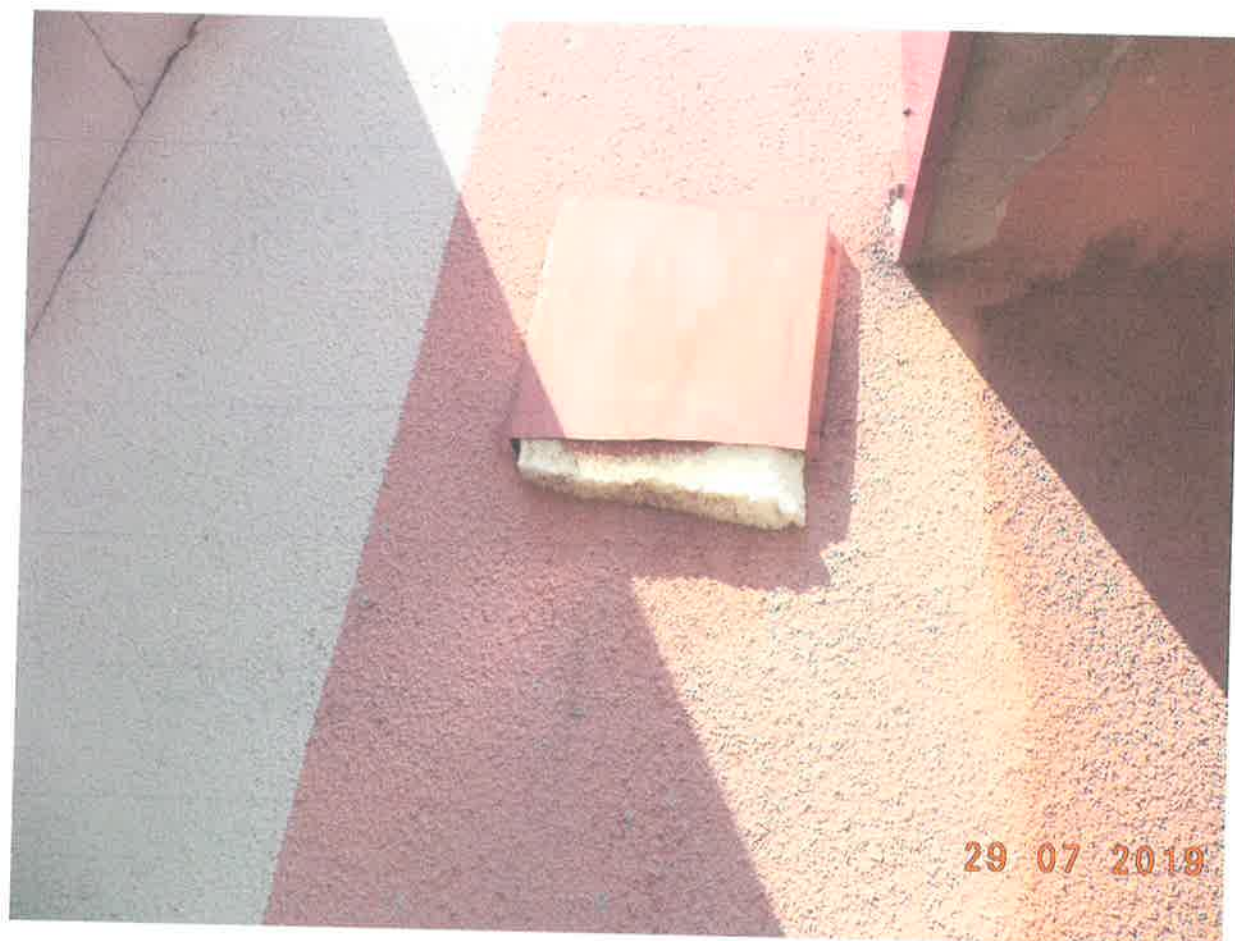
Przykład zabezpieczenia wylotu do wywietrznika (wschodnia strona budynku)
