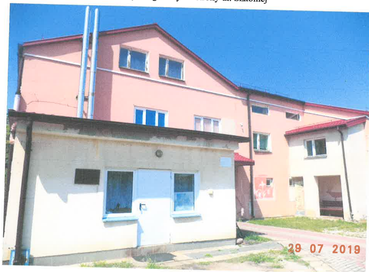
Budynek główny i wraz z pierwszym budynkiem pomocniczym od strony wschodniej
