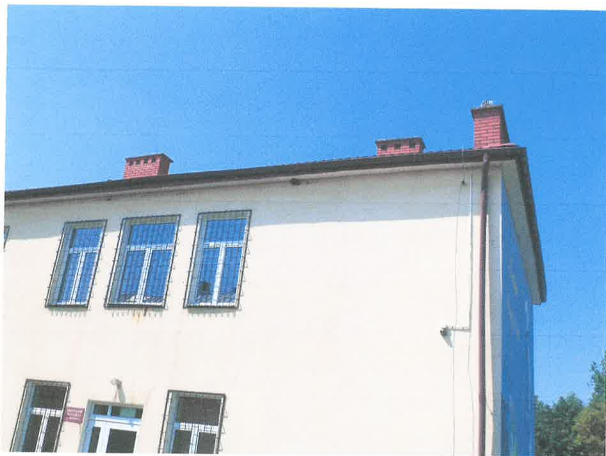
Gniazdo oknówki nr 3 na budynku głównym od strony wschodniej
