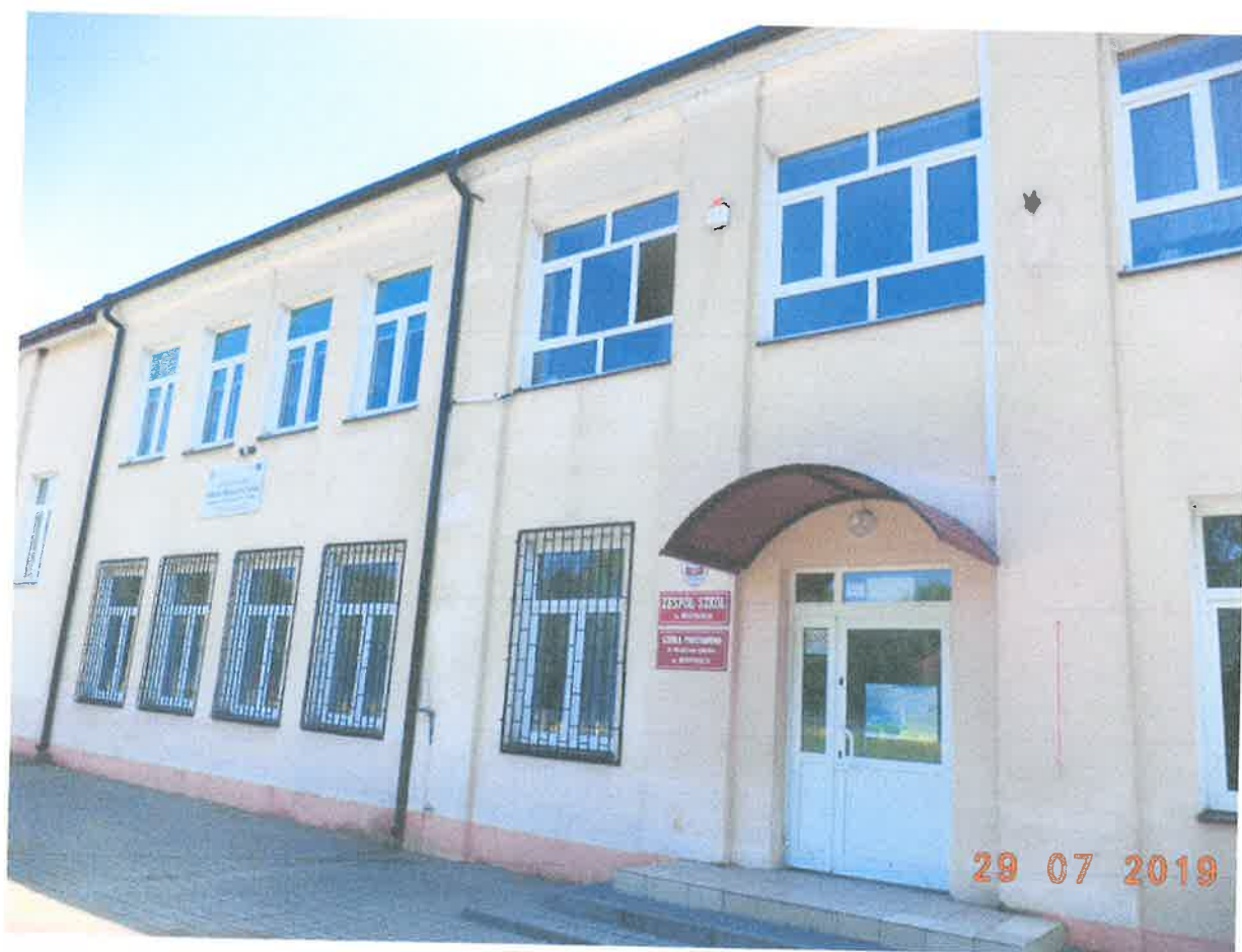
Front budynku z głównym wejściem od strony ul. Siedleckiej
