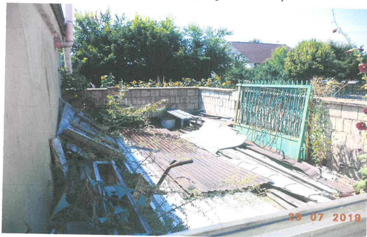
Skład materiałów przy pierwszym budynku pomocniczym od strony ul. Szkolnej
