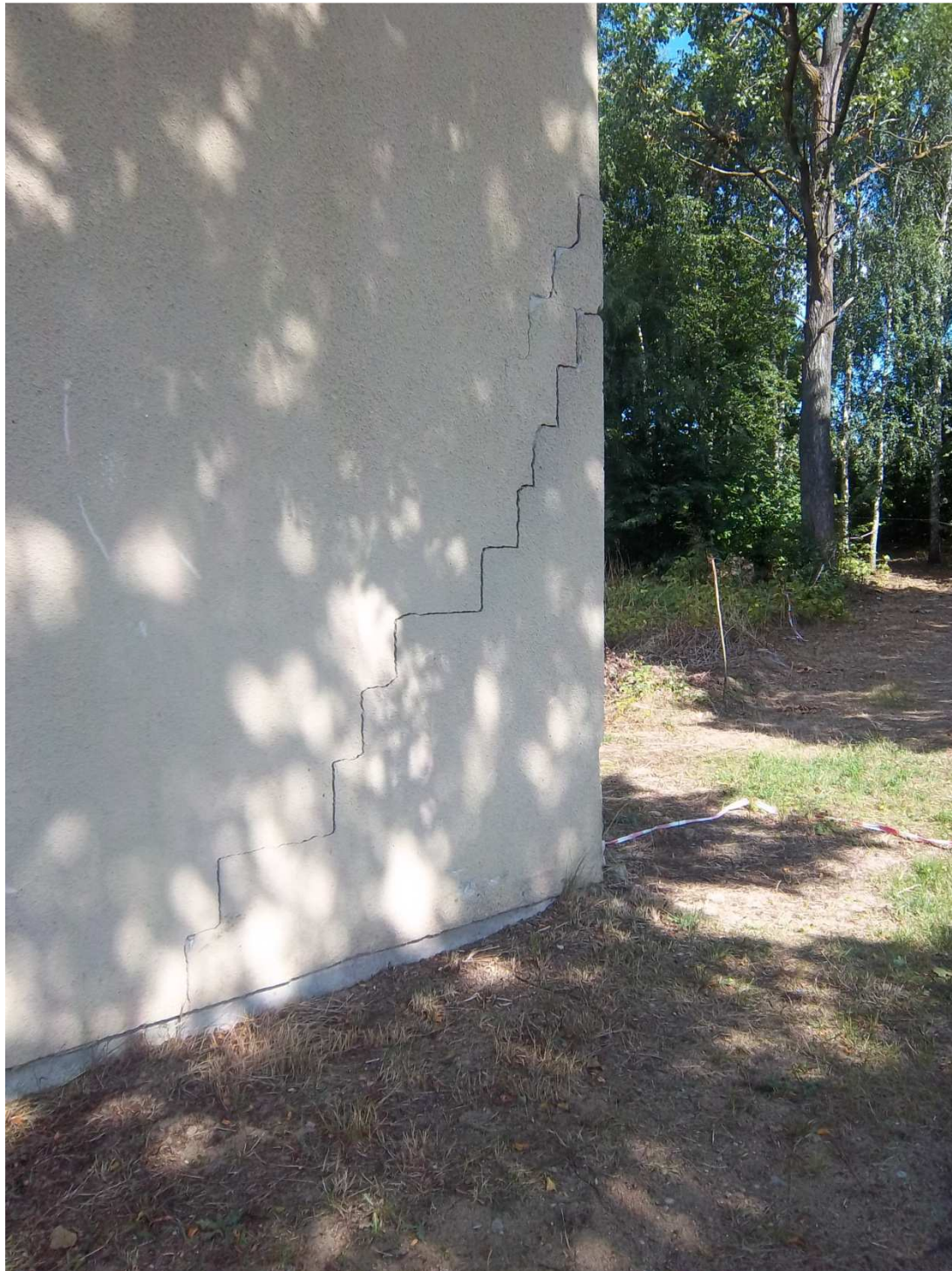
Pęknięcie zewnętrzne
