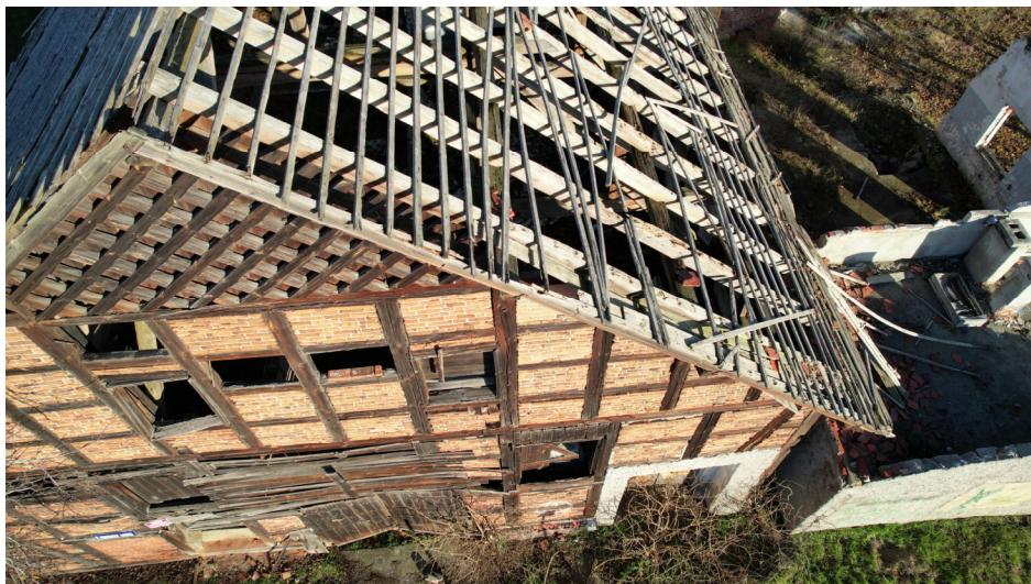
ZDJ. 13 Uszkodzenia płatwi i krokwi od strony południowo wsch.
