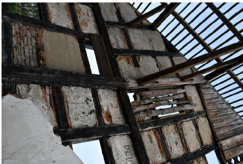
ZDJ.5 Uszkodzenia ściany naroże półn.- zach.
