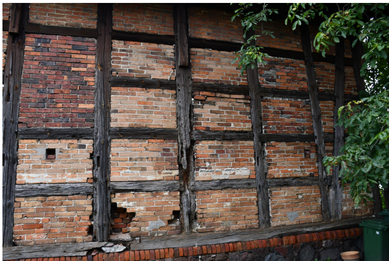
ZDJ. 11 Uszkodzenia ściany zachodniej od strony południowej.
