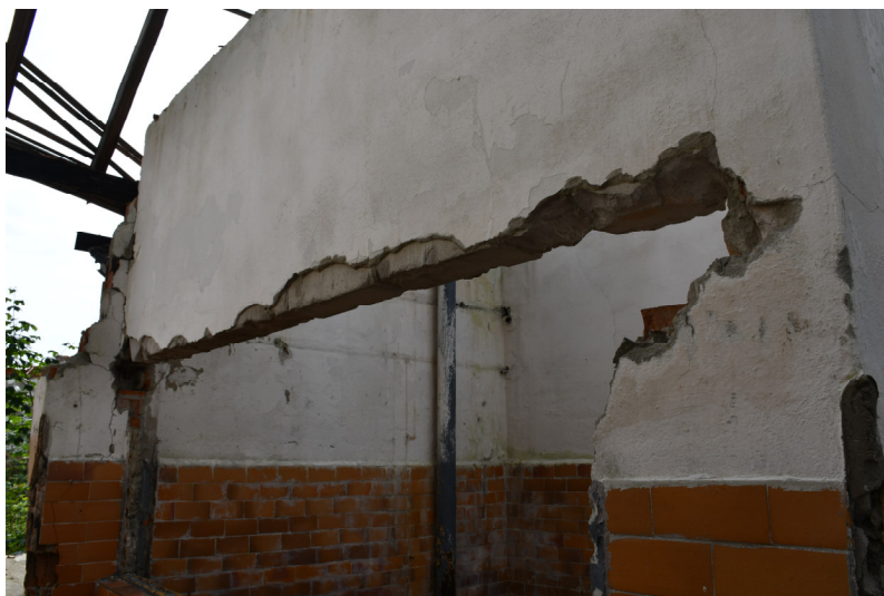
ZDJ. 8 Uszkodzenia ściany wewnętrznej.
