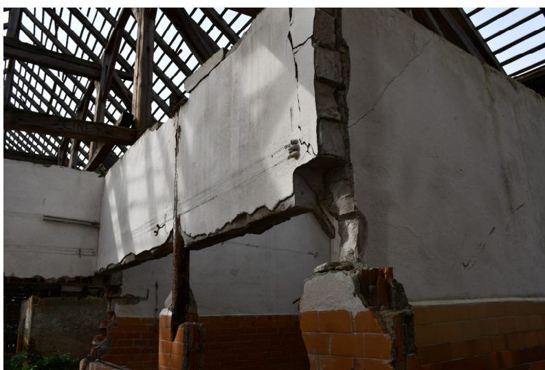
ZDJ. 9 Uszkodzenia ściany wewnętrznej.
