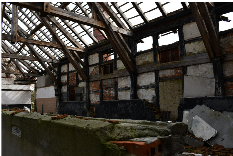
ZDJ. 7 Konstrukcja wieszakowa dachu, uszkodzenia na ścianie wsch.
