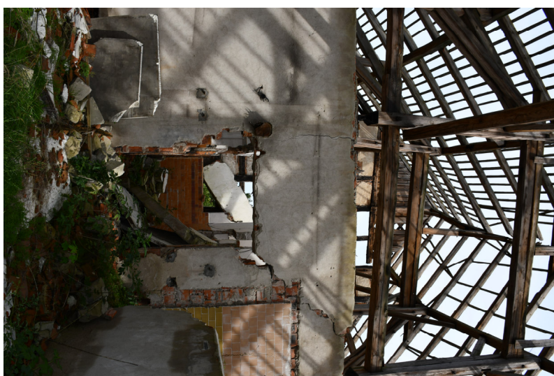
ZDJ.6 Konstrukcja wieszakowa dachu i uszkodzenia ścian wewnętrznych.
