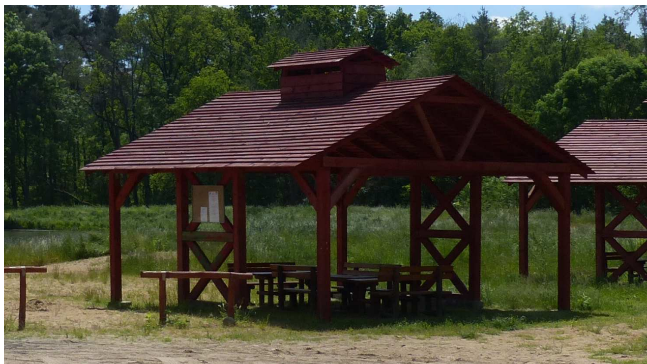
Fot. Wiata drewniana
