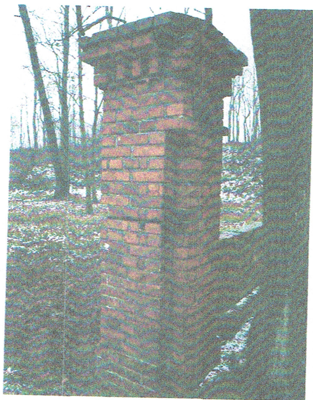
Fot. 12. Słup bramy – strona wewnętrzna z wnęką na zawiasy.
