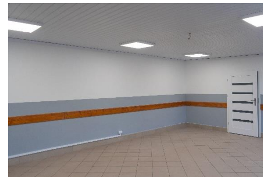
Modernizacja pomieszczeń pełniących funkcję świetlicy w budynku OSP w Chociszewie
