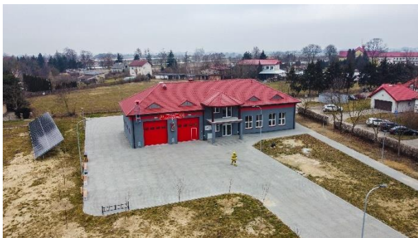
Budowa świetlicy wraz z zapleczem garażowym OSP Czerwińsk nad Wisłą
