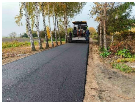
Przebudowa drogi w miejscowości Parlin
