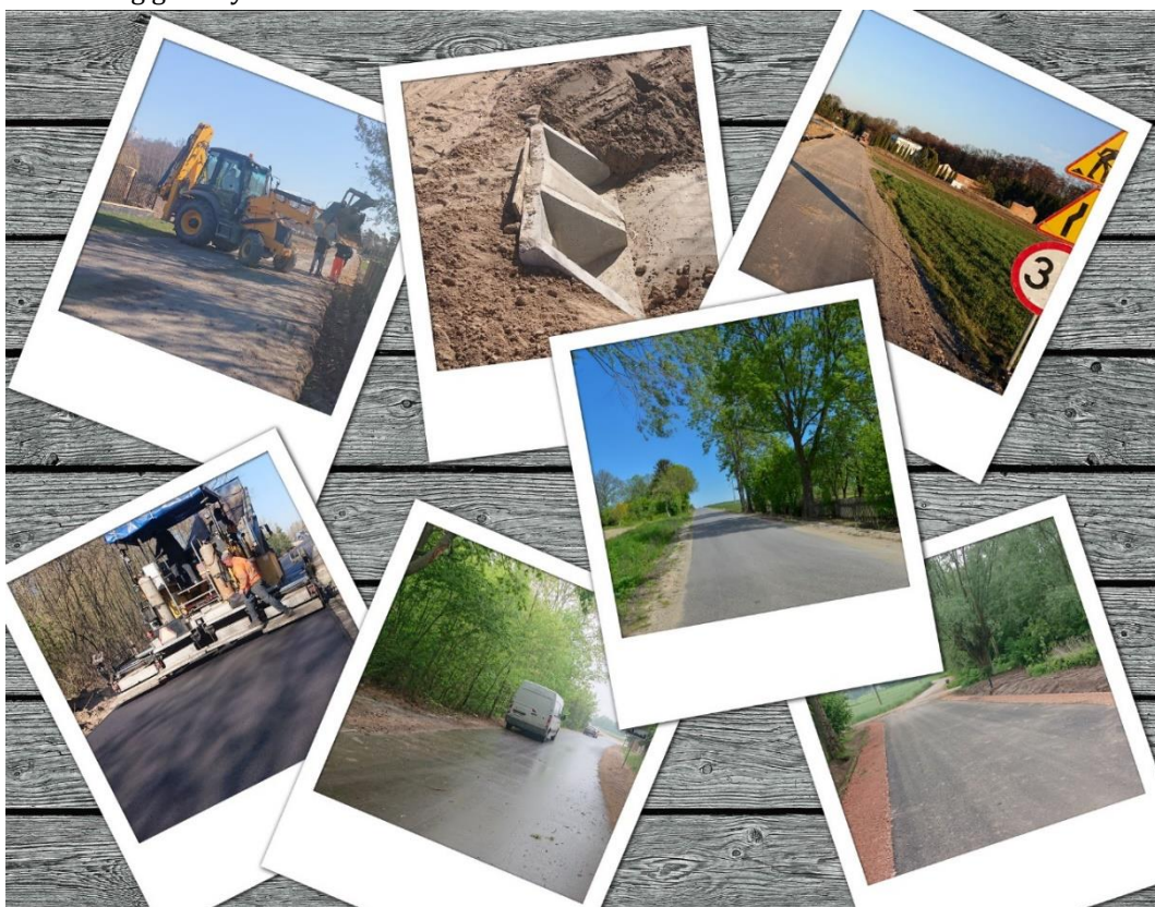
Przebudowa dróg gminnych
