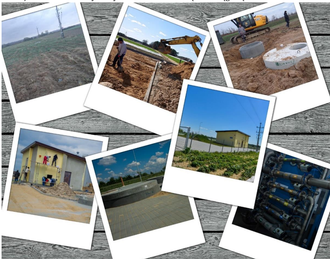
Budowa Stacji Uzdatniania Wody w Wychódzcu wraz z siecią wodociągową
