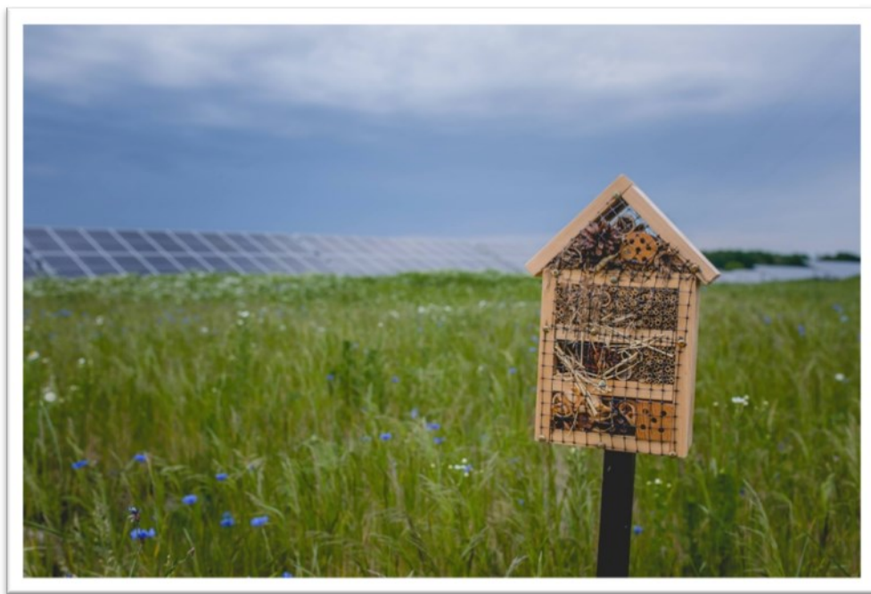
Fot. 5 Widok na elektrownię fotowoltaiczną w miejscowości Miasteczko Krajeńskie. Autor: Natalia Radtke
