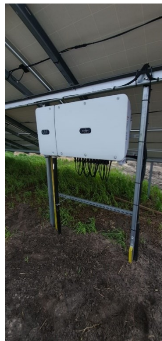
Fot. 2 Przykład inwertera i sposób jego montażu. Materiały Wnioskodawcy.
