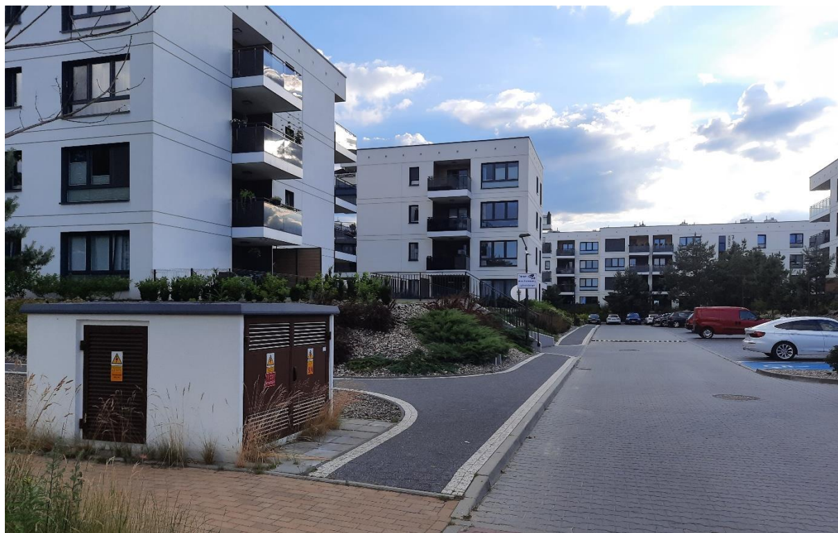
Rycina 10. Standardowa stacja kontenerowa w otoczeniu zabudowy.
