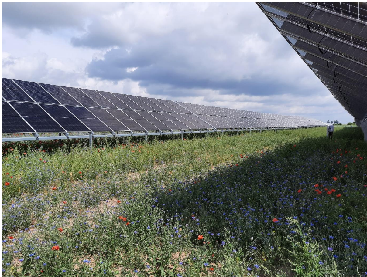
Rycina 1. Powierzchnia biologicznie czynna pod panelami fotowoltaicznymi.
