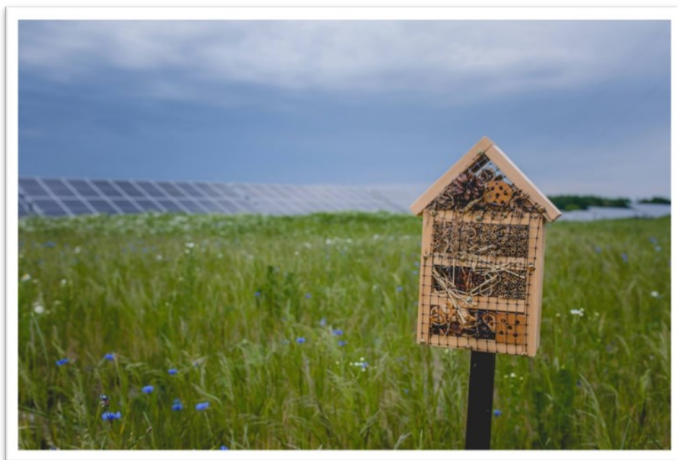
Rysunek 28 Widok na elektrownię fotowoltaiczną w miejscowości Miasteczko Krajeńskie. Autor: Natalia Radtke
