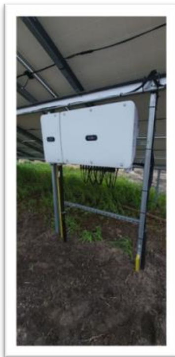
Fot. 2 Przykład inwertera i sposób jego montażu. Materiały Wnioskodawcy.
