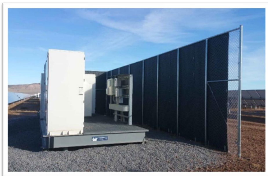
Rysunek 35 Przykład zastosowania membrany o grubości 1/8 cala, która drga wraz z dźwiękiem, przekształcając w ten sposób energię dźwiękową w wewnętrzną, niesłyszalną energię tarcia xl
