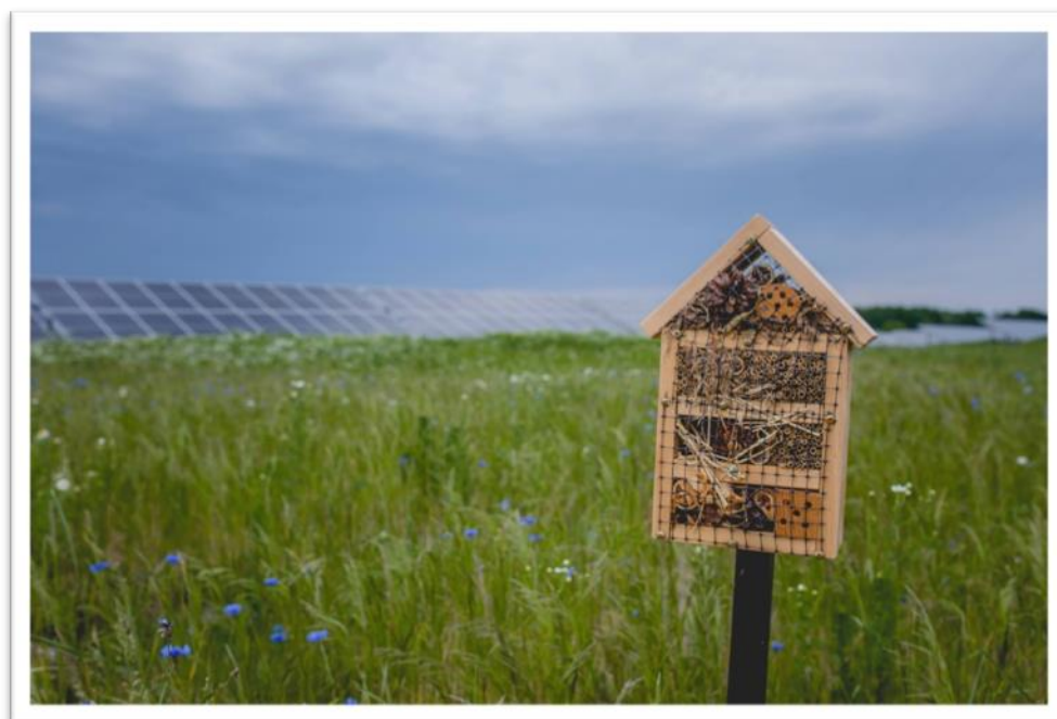
Rysunek 27 Widok na elektrownię fotowoltaiczną w miejscowości Miasteczko Krajeńskie. Autor: Natalia Radtke
