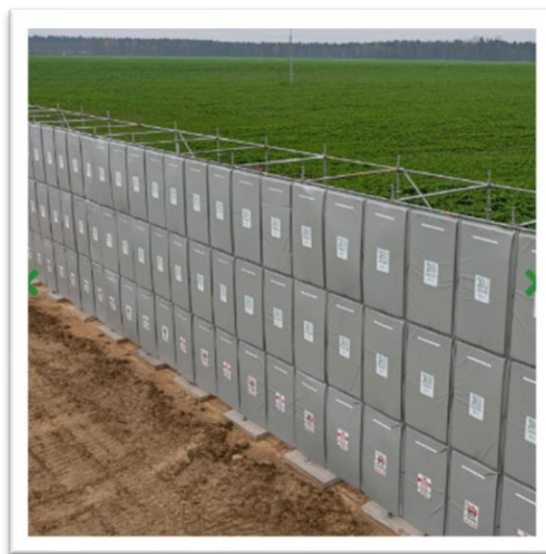
Rysunek 33 Przykład zastosowania tymczasowych mat dźwiękochłonnych. [źródło: exflo.pl]
