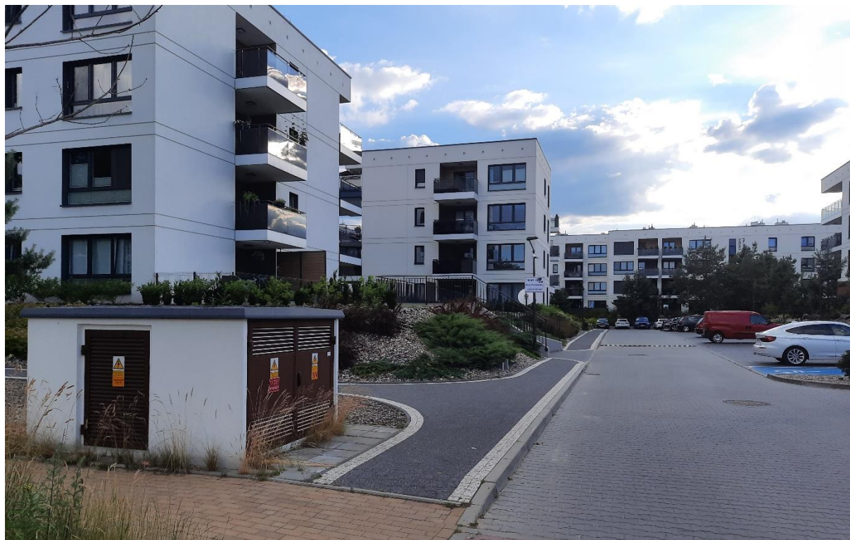
Rycina 10. Standardowa stacja kontenerowa w otoczeniu zabudowy.
