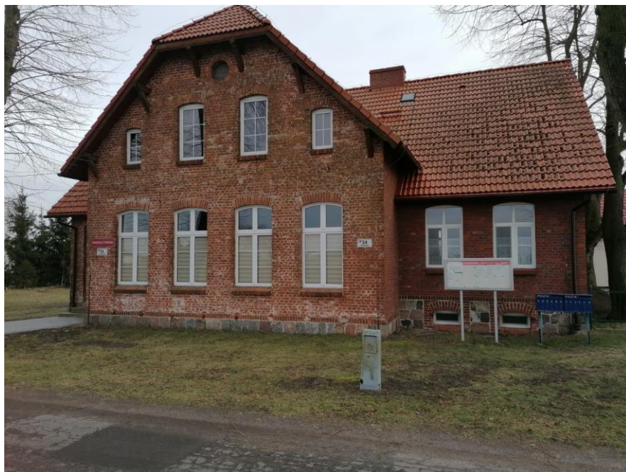
Fot. nr 4. Budynek świetlicy
