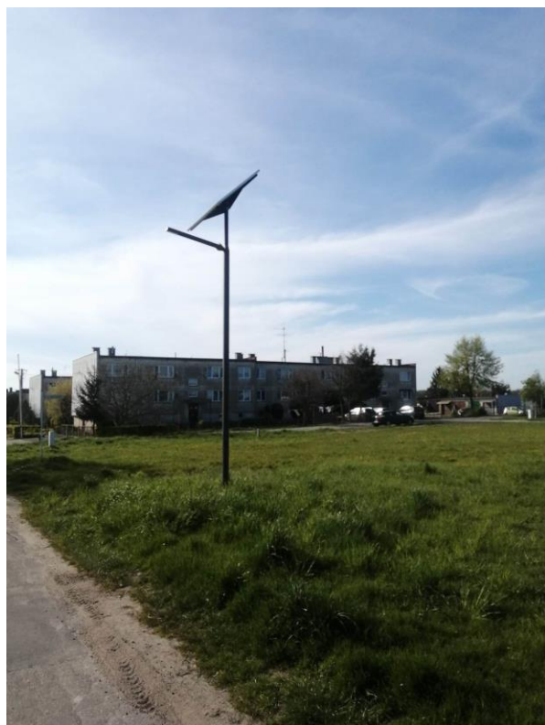
Lampa solarna w miejscowości Micharzewo
