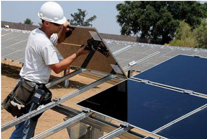
Fot. 3 Montaż modułów na stelażach – przykład
