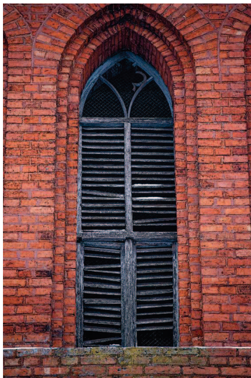
↑ Fot. Powyżej stan zachowania : żaluzja typ Z-1 – do renowacji ↓ Fot. Poniżej: widok od środka
