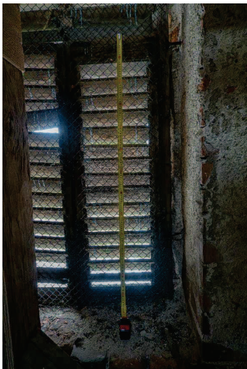
↑ Fot. Powyżej stan zachowania : żaluzja typ Z-1 – do renowacji ↓ Fot. Poniżej: widok od środka
