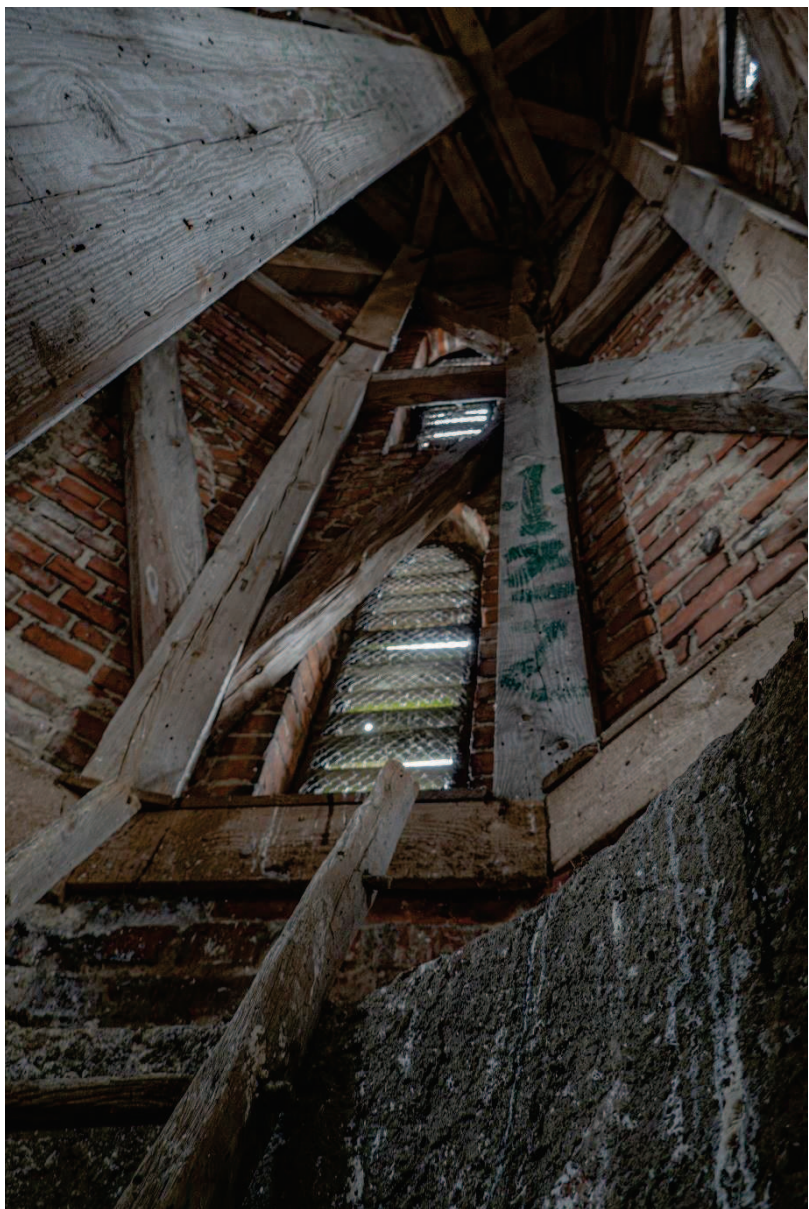
↑Fot. Powyżej stan zachowania : żaluzja typ Z-3 i Z-4 – widok od środka
