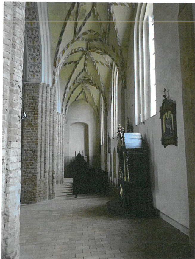
Fot.61 Widok na zachodnią część nawy północnej
