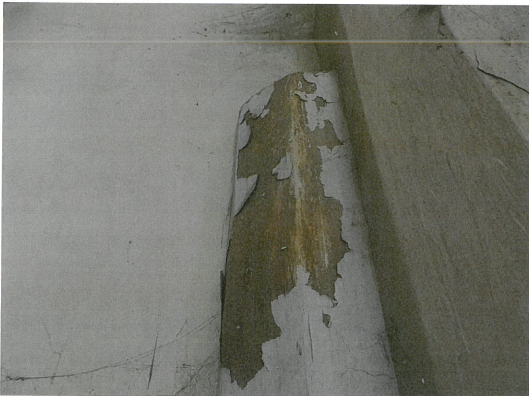
Fot. 10 Rozwarstwienie warstw malarskich
