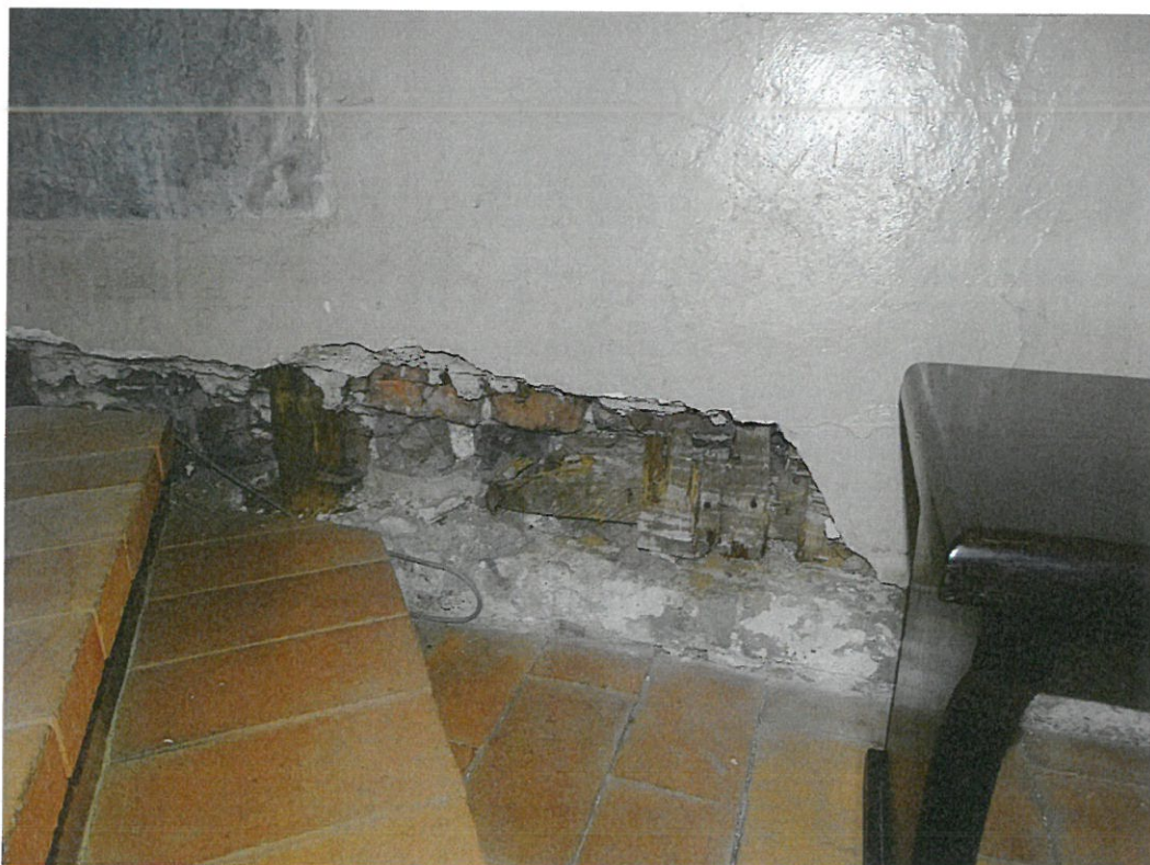
Fot. 16 Drewniane ścianki dystansowe na stelażu, obite matą trzcinową i zatynkowane
