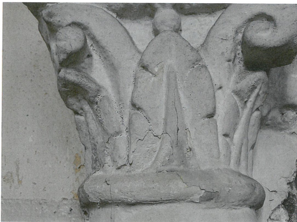
Fot. 8 Zatarty relief przez nawarstwienia farb na sakramentarium
