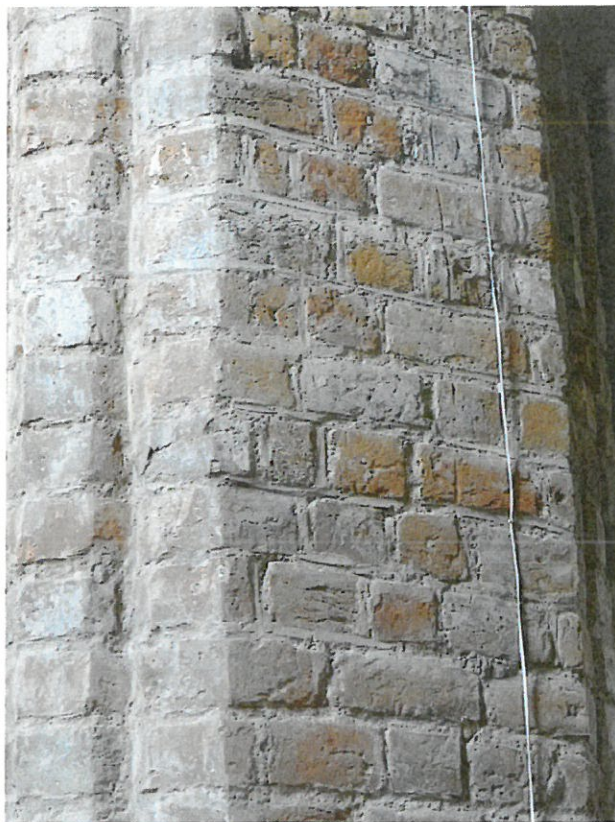
Fot. 41 Wyeksponowany wątek ceglany i odsłonięte, starannie opracowane spoiny
