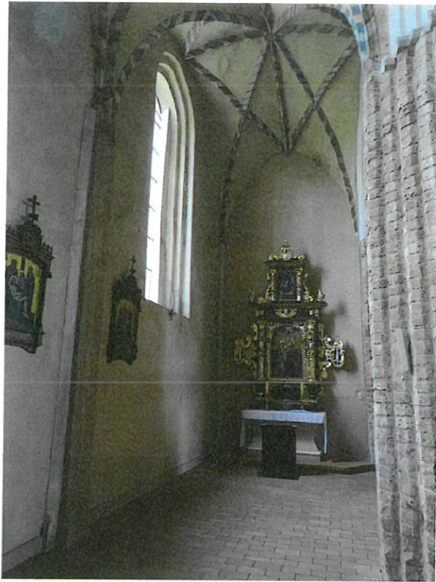
Fot.62 Widok na wschodnią część nawy północnej z ołtarzem bocznym
