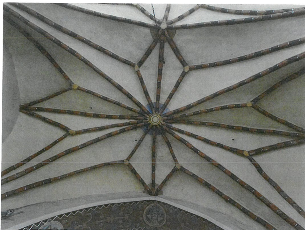
Fot.48 sklepienie nad prezbiterium
