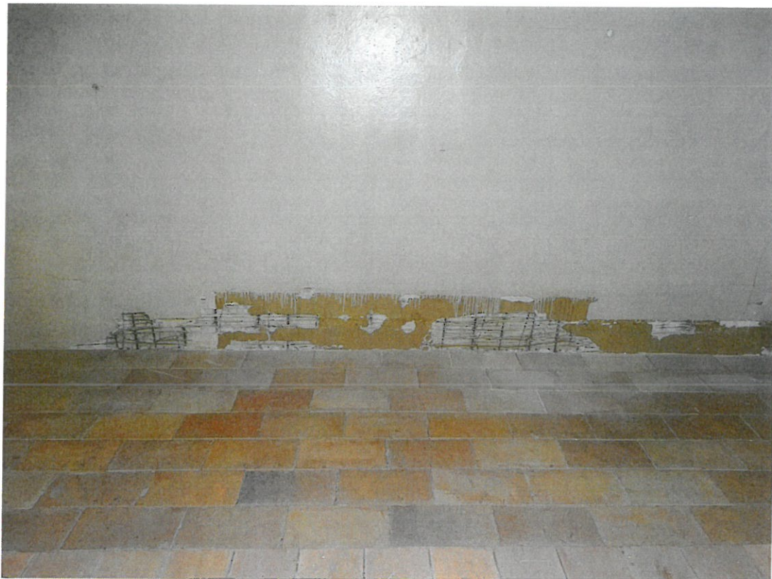
Fot. 15 Drewniane ścianki dystansowe na stelażu, obite matą trzcinową i zatynkowane
