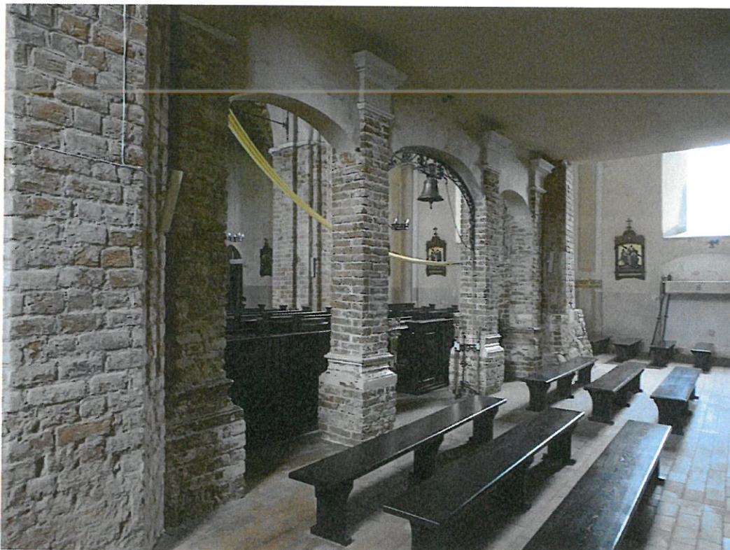
Fot. 38 Usunięty tynk oraz oczyszczone cegły filarów międzynawowych
