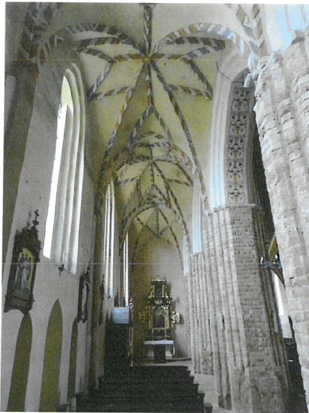
Fot.60 Widok na wschodnią część nawy północnej
