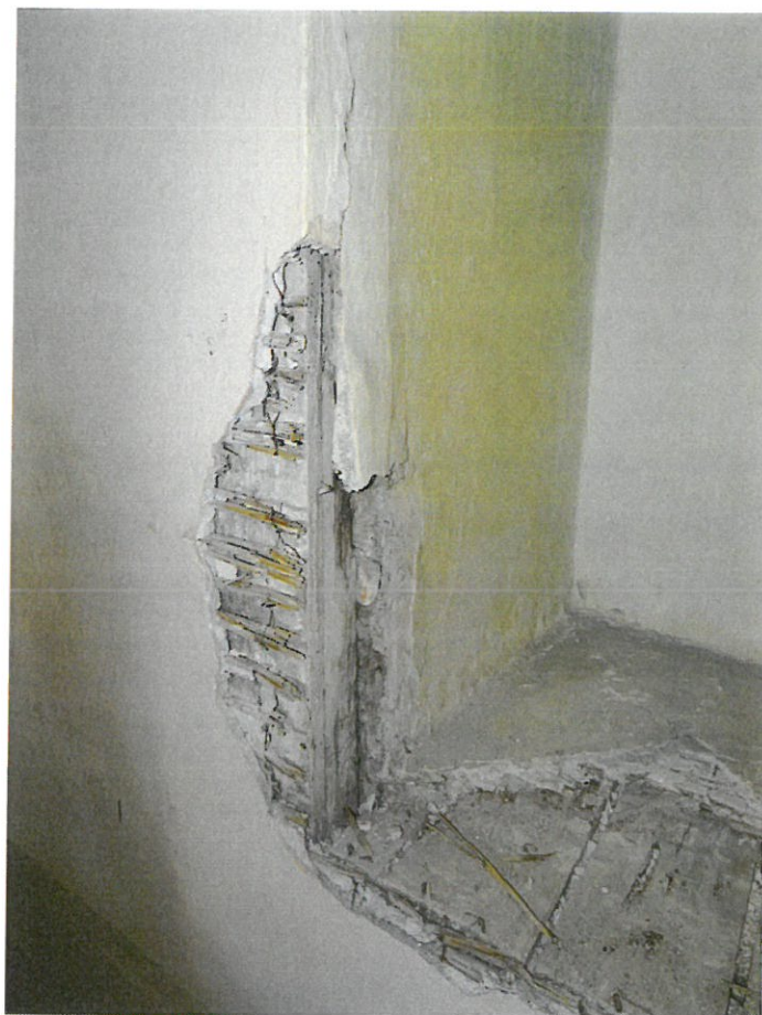
Fot. 17 drewniane ścianki dystansowe na stelażu, obite matą trzcinową i zatynkowane
