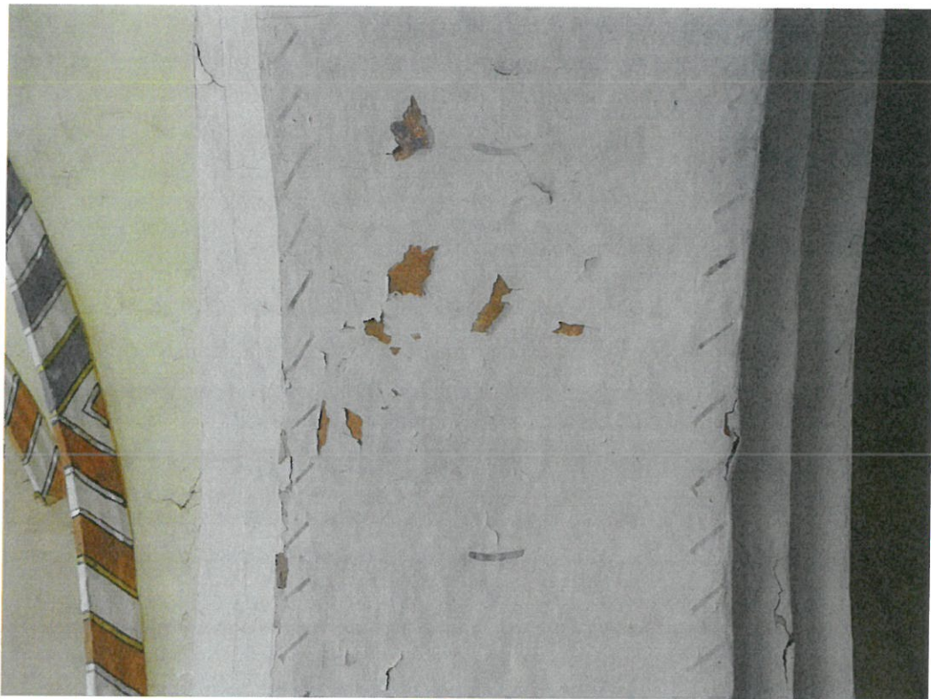
Fot. 9 Rozwarstwienie warstw malarskich
