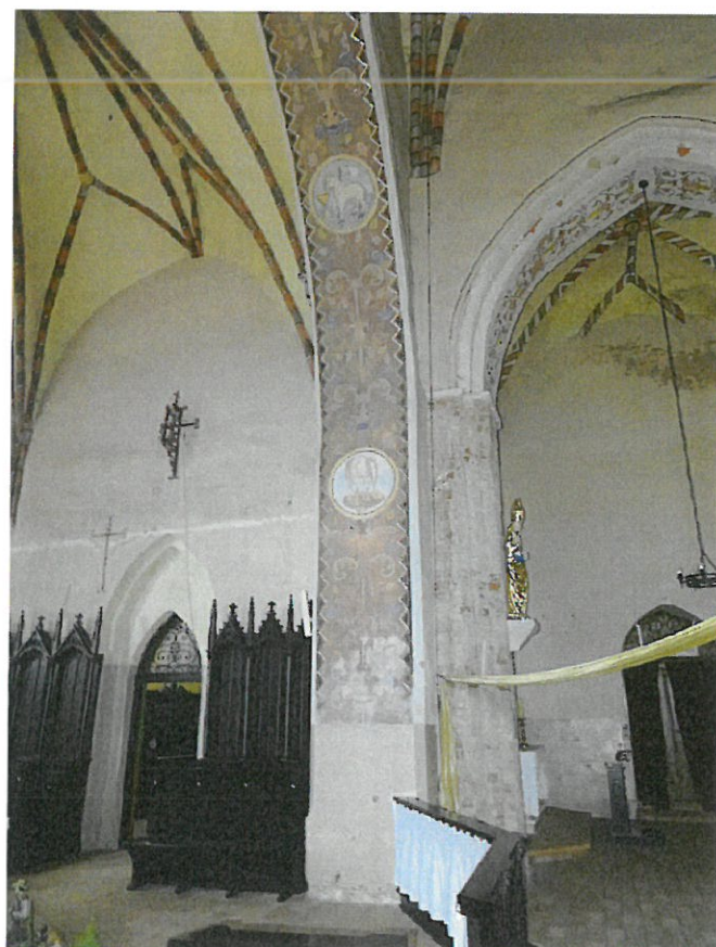
Fot.53 Łuk tęczy i południowa część ścian kościoła
