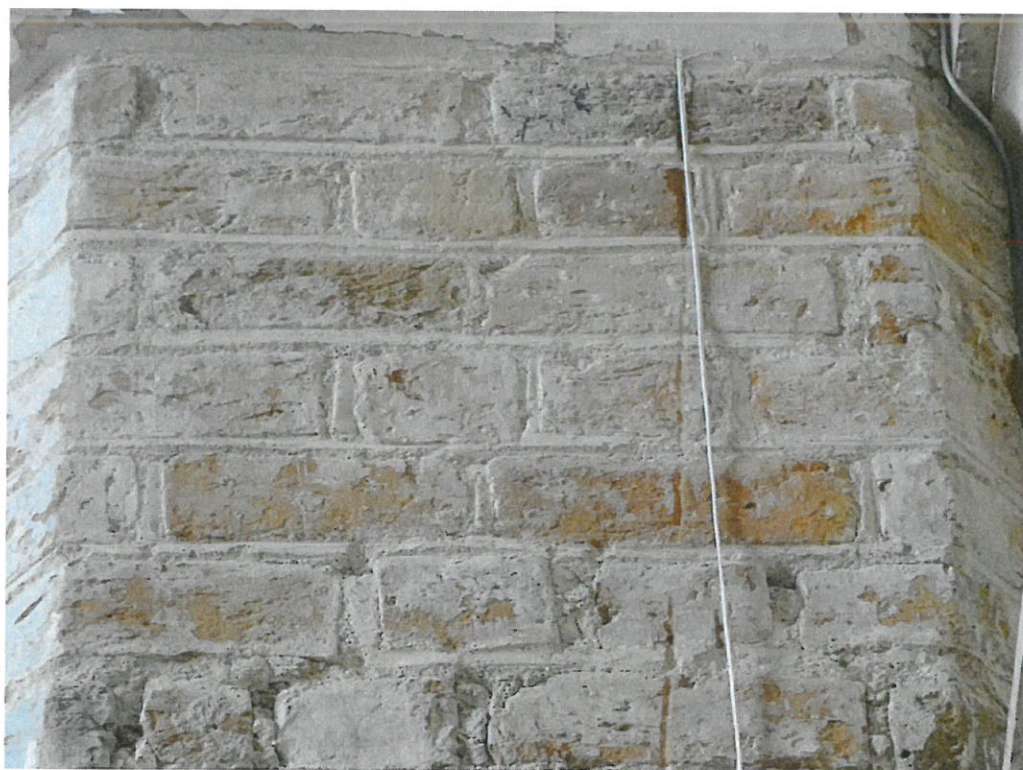
Fot. 40 Wyeksponowany watek ceglany i odsłonięte, starannie opracowane spoiny
