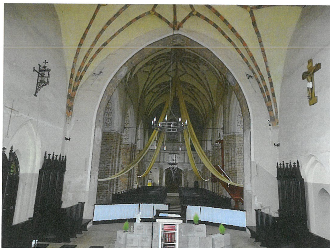
Fot.49 Widok na część zachodnią prezbiterium
