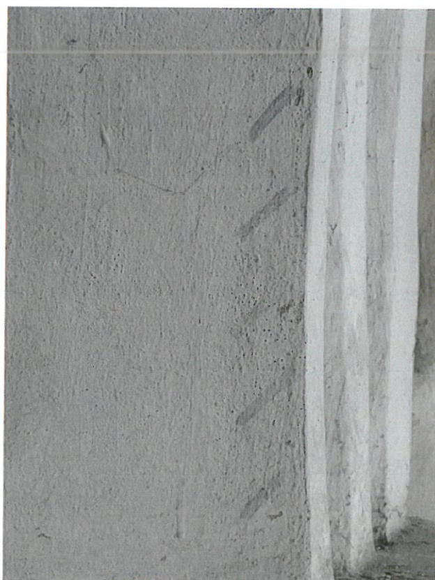
Fot. 34 Ślady wcześniejszych dekoracji w formie regularnych ciemniejszych przebarwień
