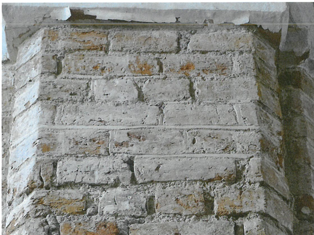
Fot. 42 Wyeksponowany wątek ceglany i odsłonięte, starannie opracowane spoiny
