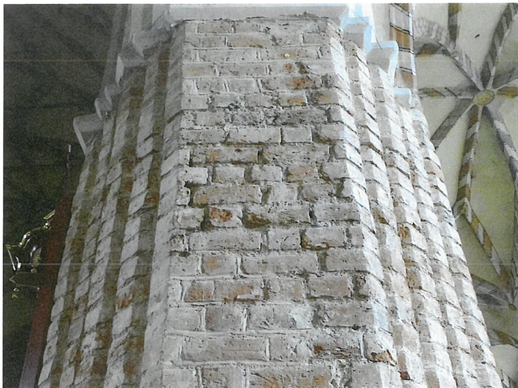
Fot. 43 Wyeksponowany watek ceglany i odsłonięte, starannie opracowane spoiny
