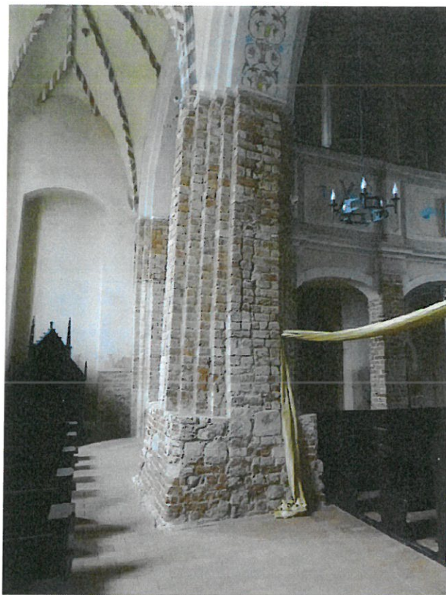
Fot. 39 Usunięty tynk oraz oczyszczone cegły filarów międzynawowych
