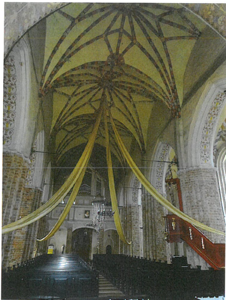
Fot.54 Zachodnia część nawy głównej
