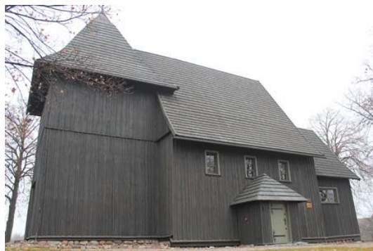
Fot. 12. Kościół w Tarnowie Pałuckim Źródło: GEZ
