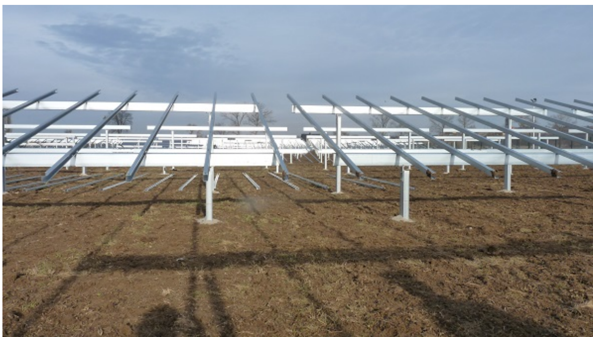
Ryc. 5. Przykładowa konstrukcja stalowa- stelaż pod panele fotowoltaiczne
