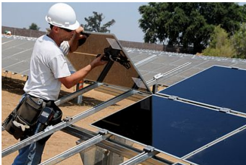
Ryc. 8. Montaż paneli na stelażach – przykład
