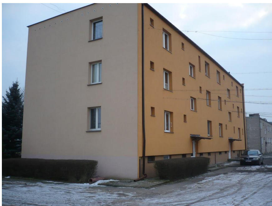
Wielorodzinny budynek mieszkalny – termoizolacja
