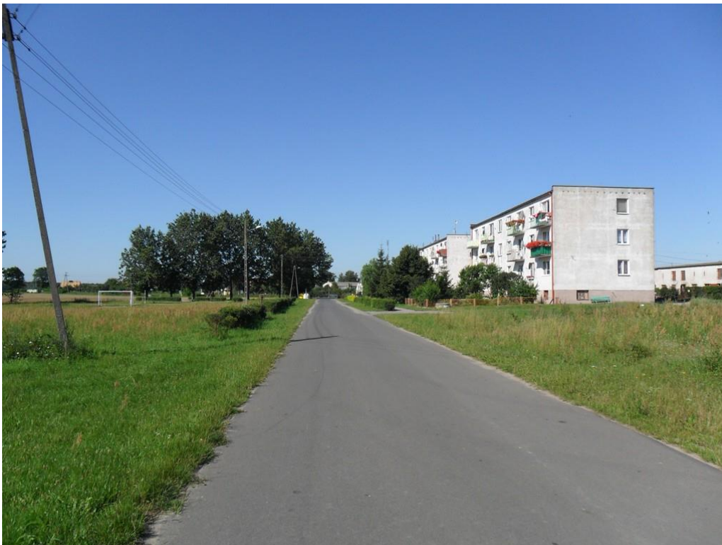
Droga gminna na terenie wsi Nowe.
