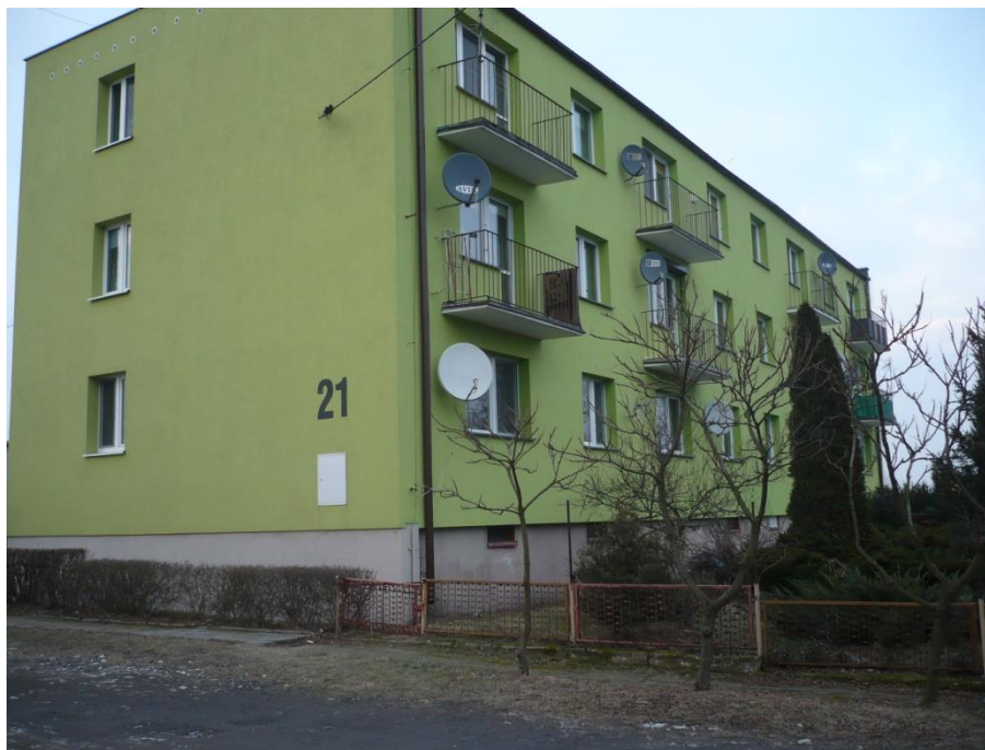
Wielorodzinny budynek mieszkalny – termoizolacja
