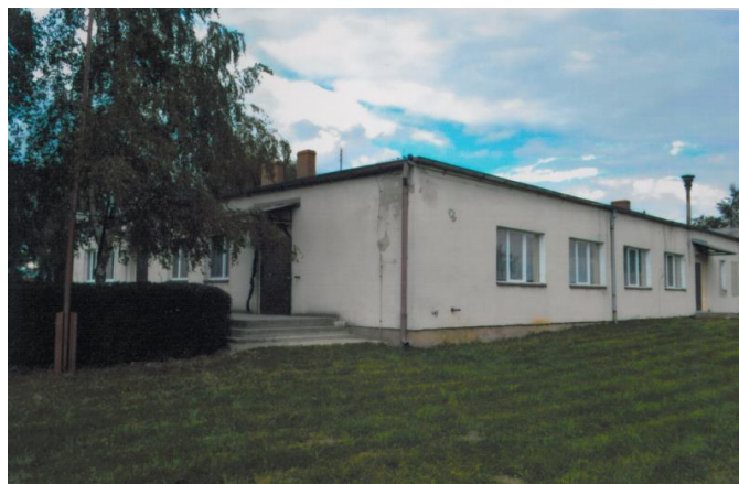
Budynek świetlicy wiejskiej przed przebudową.
