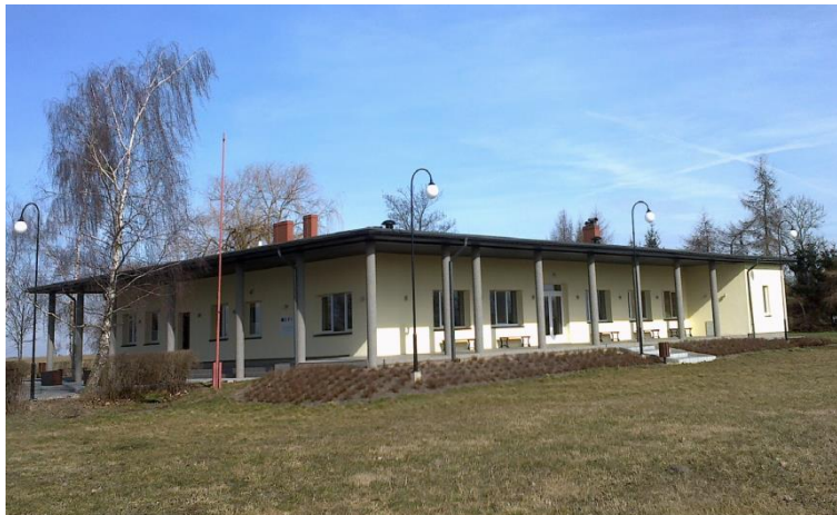
Budynek świetlicy wiejskiej po przebudowie w 2013 r.
