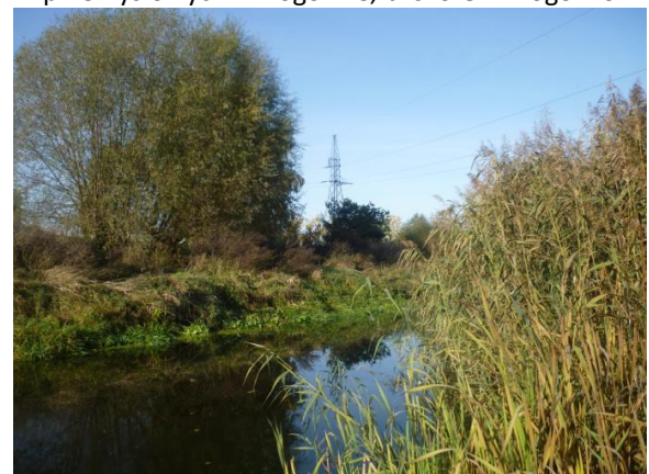
Fot. 12. Istniejąca linia 110 kV przechodząca przez dolinę Wełny przylegającą do terenów przemysłowych w Rogoźnie, blisko GZP Rogoźno
