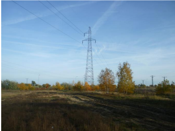
Fot. 1. Miejsce wyjścia przebudowywanej linii z GPZ Wągrowiec
