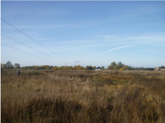
Fot. 9. Istniejąca linia 110 kV przechodząca przez dolinę Wełny na północ od Rogoźna
