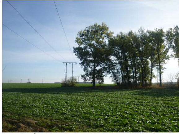
Fot. 8. Istniejąca linia 110 kV w rejonie Marlewa
