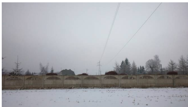
Pas techniczny linii wysokiego napięcia
