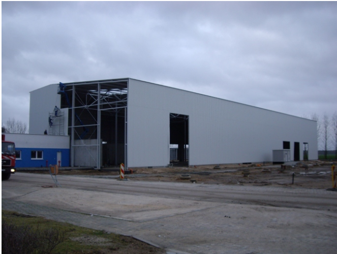
Fot.1. Hala sortowni
