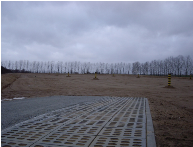
Fot.2. Kwatera składowiska II
