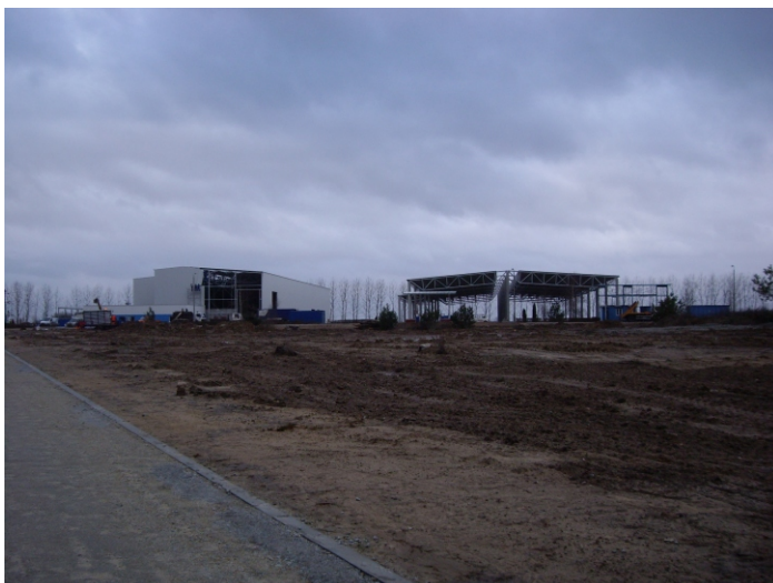
Fot.3. Hala sortowni i wiata kompostowni (do przebudowy na halę)
