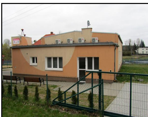
Świetlica wiejska oraz OSP
