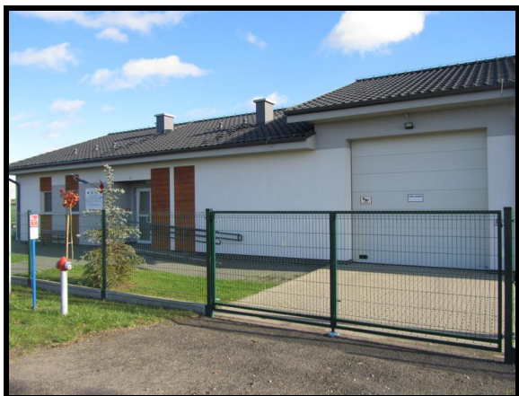
Świetlica wiejska oraz OSP
