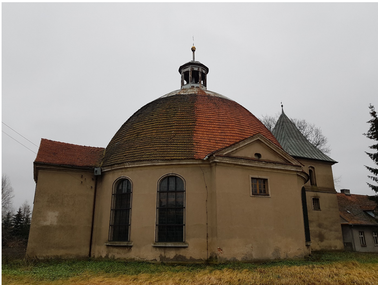
Rycina 31. Kościół pw. Ducha Św. w Murowanej Goślinie
