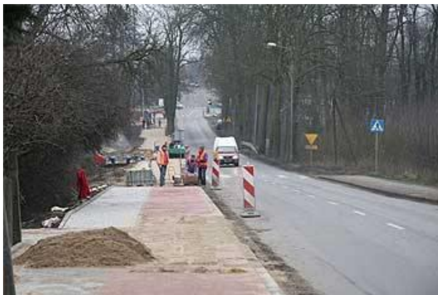
Rysunek 2.3. Przebędowo – droga powiatowa nr 2513P
