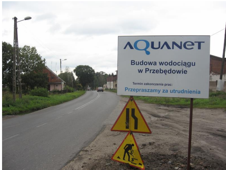
Rysunek 3.4. Przebędowo – budowa wodociągu
