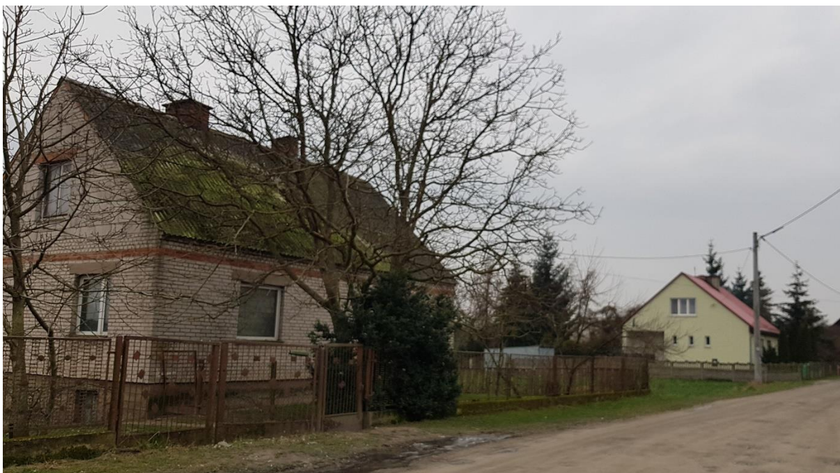
Rycina 31. Przykład zabudowy jednorodzinnej zagrodowej w Starczanowie
