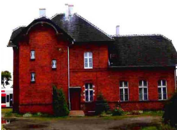
Rysunek 3.5. Dworzec kolejowy
