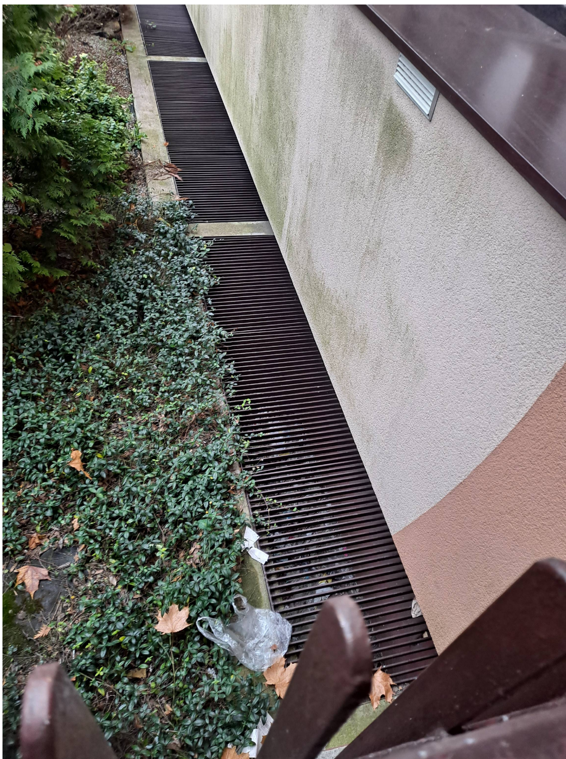
Fot.2. Studzienki piwniczne wzdłuż elewacji budynku– głębokość studzienek ok. 80cm
