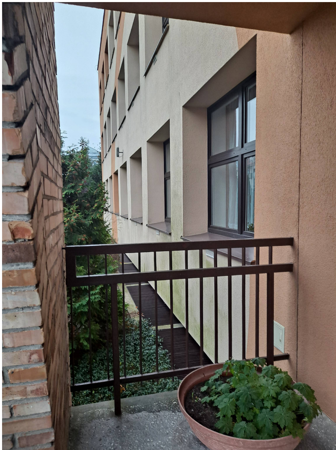
Fot.1. Słup przy schodach wejściowych- miejsce planowanej pochylni -usunięciu podlega balustrada, słup nie koliduje z planowaną inwestycją
