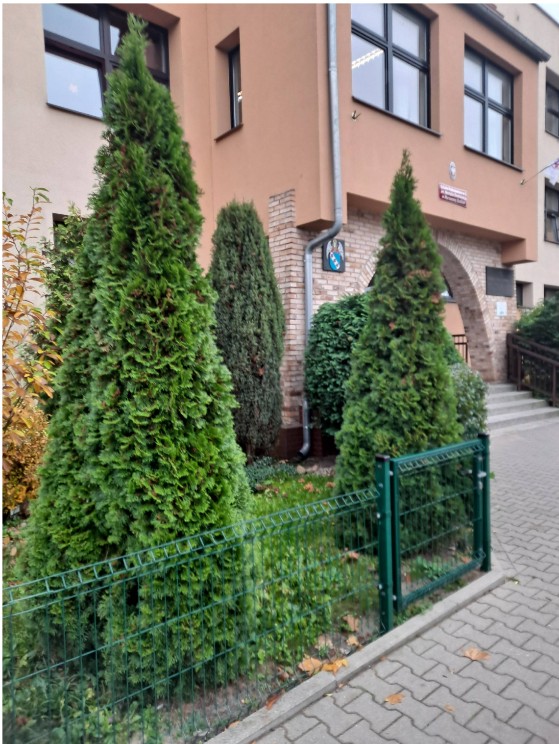
Fot.3. Fragment wejścia głównego i ogrodzenia do demontażu
