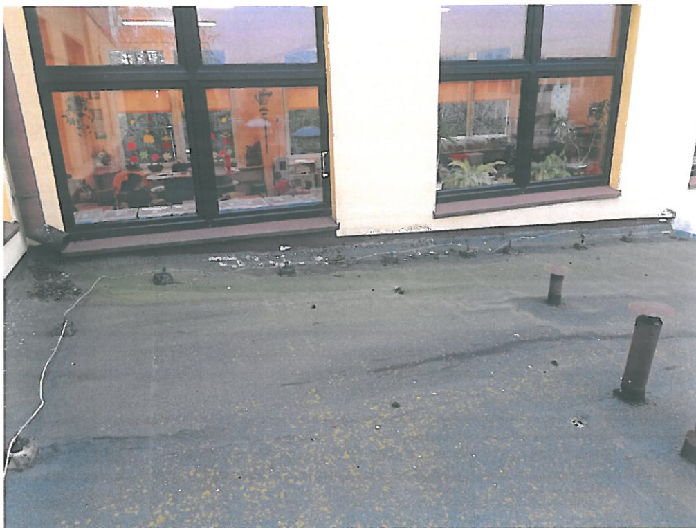
Naprawa pokrycia dachowego na budynku przedszkola „SŁONECZKO” wraz z dociepleniem stropodachu wentylowanego
