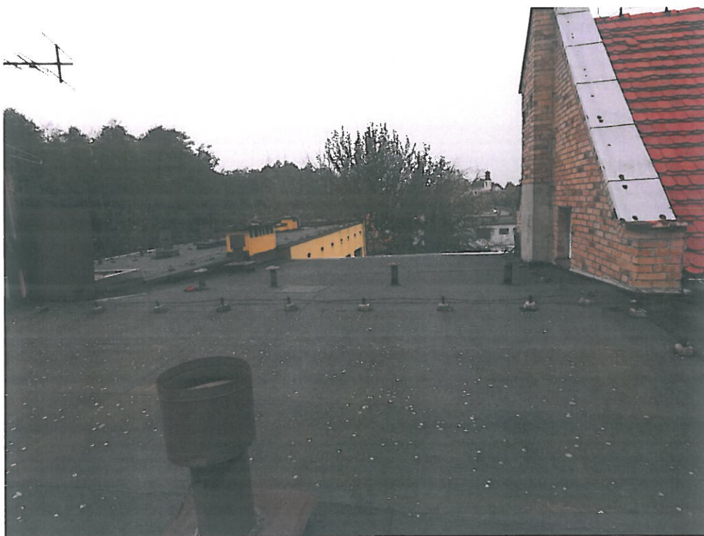
Naprawa pokrycia dachowego na budynku przedszkola „SŁONECZKO” wraz z dociepleniem stropodachu wentylowanego
