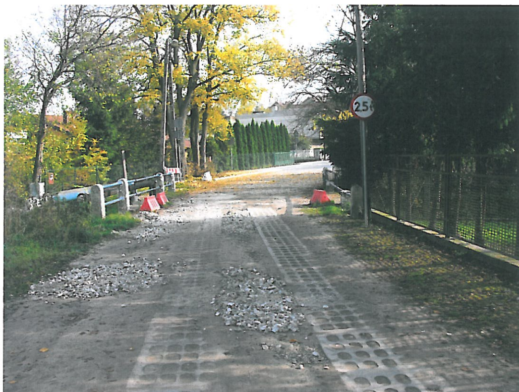
Fot. nr 2 - Widok na jezdnię od strony zachodniej
