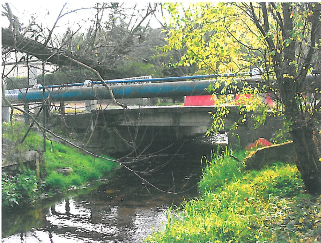
Fot. nr 3 – Widok na obiekt od strony północnej (górnej wody)
