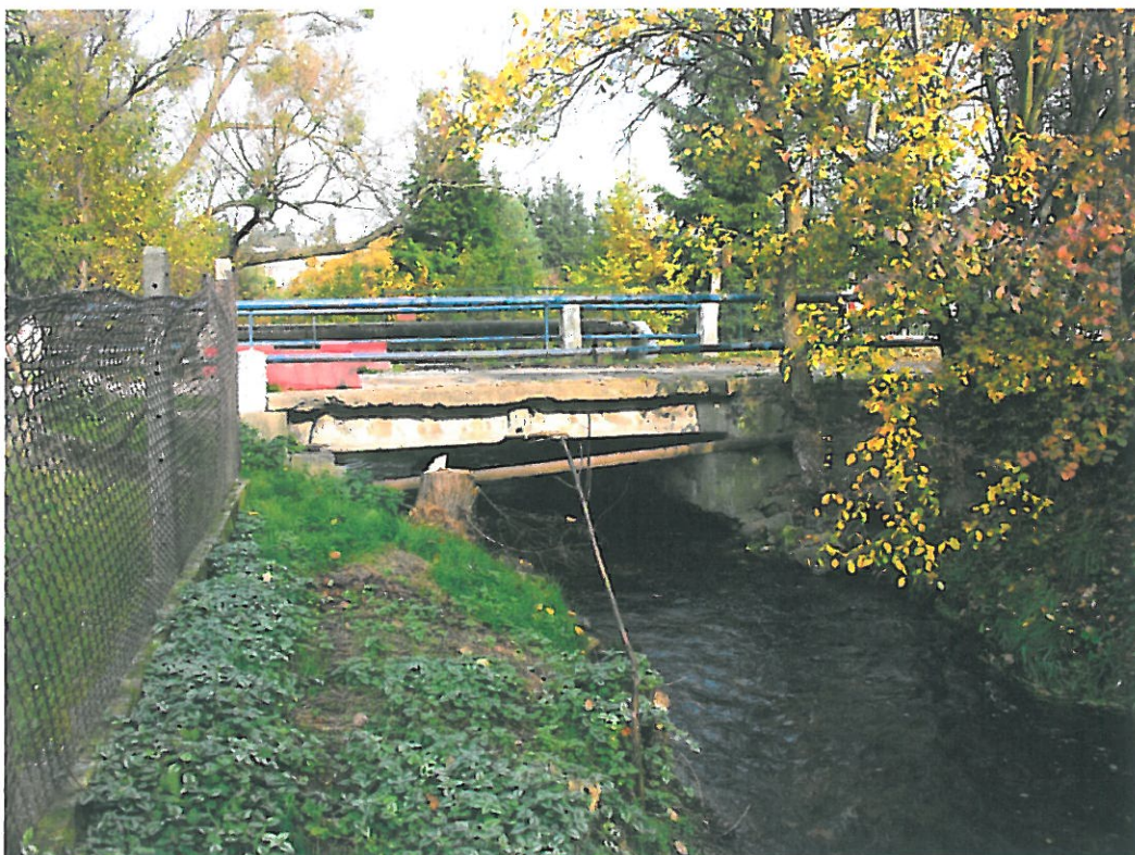
Fot. nr 4 – Widok na obiekt od strony południowej (dolnej wody)
