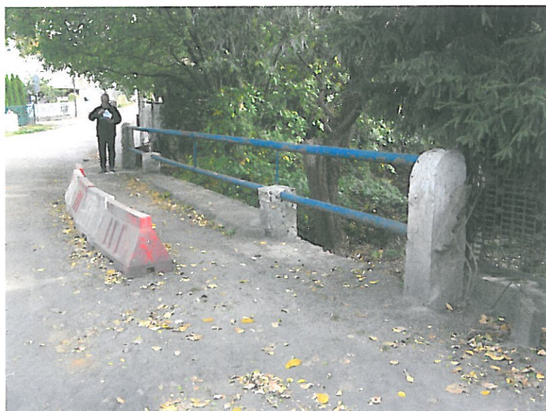
Fot. 1.2 widok mostu od strony ul. Spokojnej
