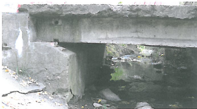
Fot. 2.1 i fot. 2.2 uszkodzenia płyty pomostu i belek – widok od strony górnej wody
