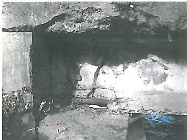
Fot. 2.3 i fot. 2.4 uszkodzenia płyty i belek – widok od strony dolnej wody
