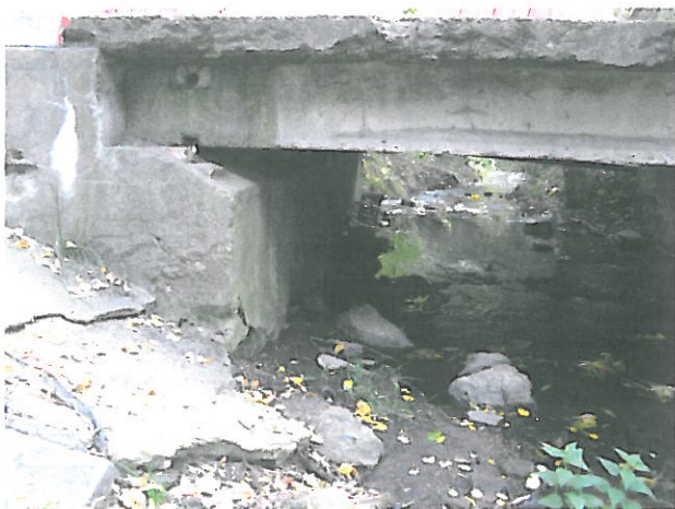
Fot. 2.6 i 2.7 ubytki betonu i pęknięcia – korpusy przyczółków
