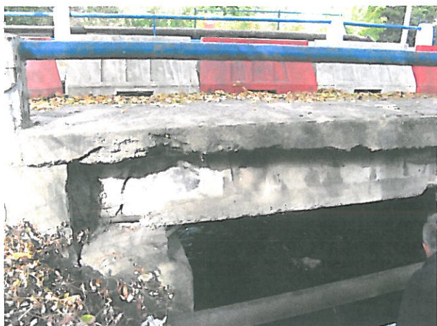
Fot. 2.3 i fot. 2.4 uszkodzenia płyty i belek – widok od strony dolnej wody
