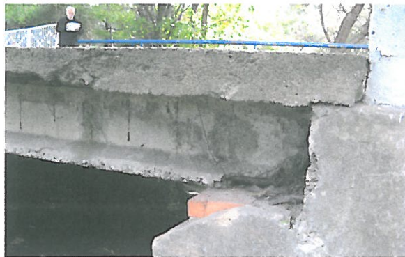
Fot. 2.1 i fot. 2.2 uszkodzenia płyty pomostu i belek – widok od strony górnej wody
