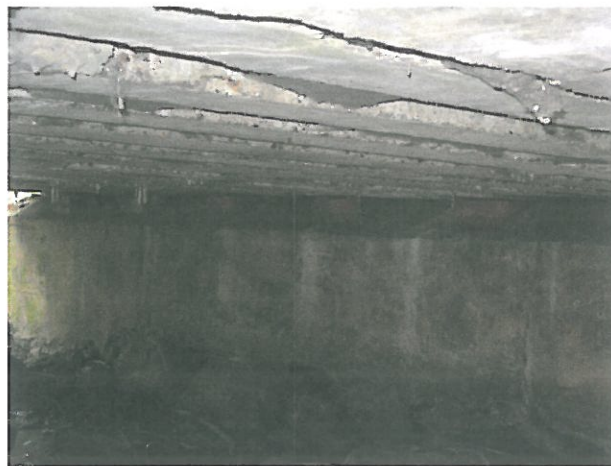
Fot. 2.6 i 2.7 ubytki betonu i pęknięcia – korpusy przyczółków
