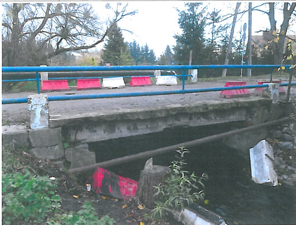
Fot. 1. Widok mostu od strony dolnej wody
