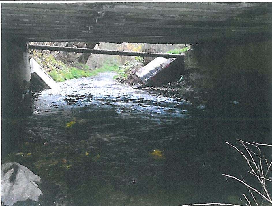
Fot. 2. Widok przeszkody i przestrzeni podmostowej
