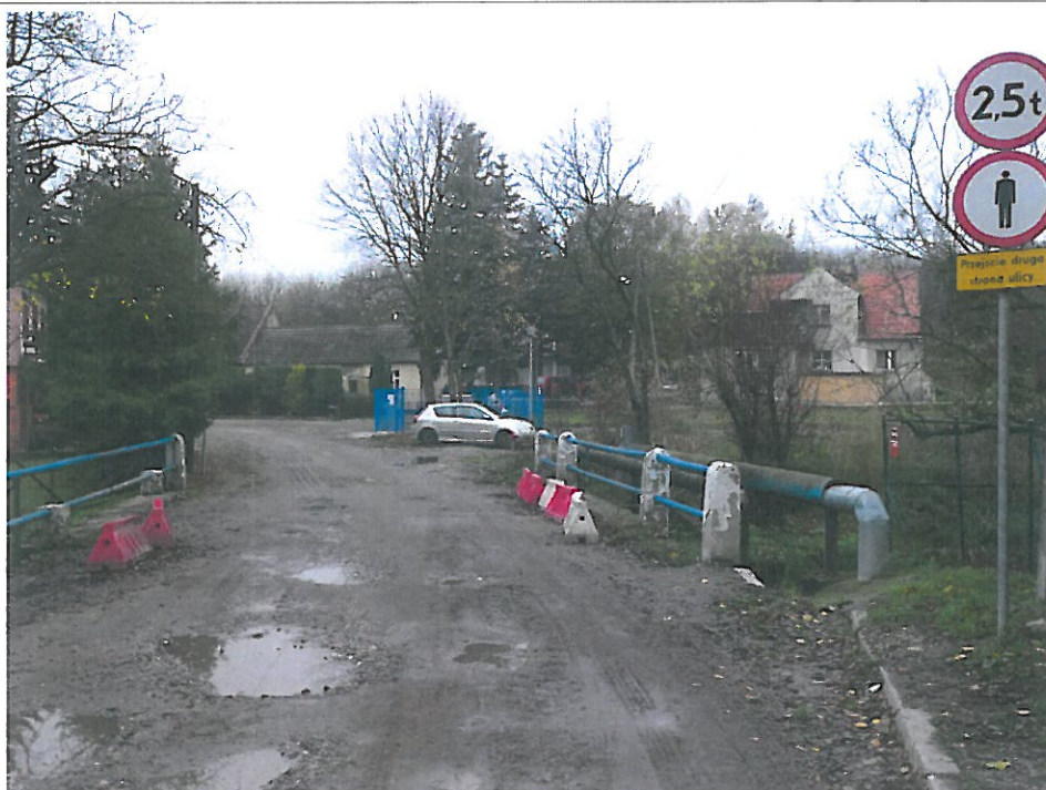
Fot. 4. Droga na obiekcie i dojazdach – widok w kierunku Raduszyna
