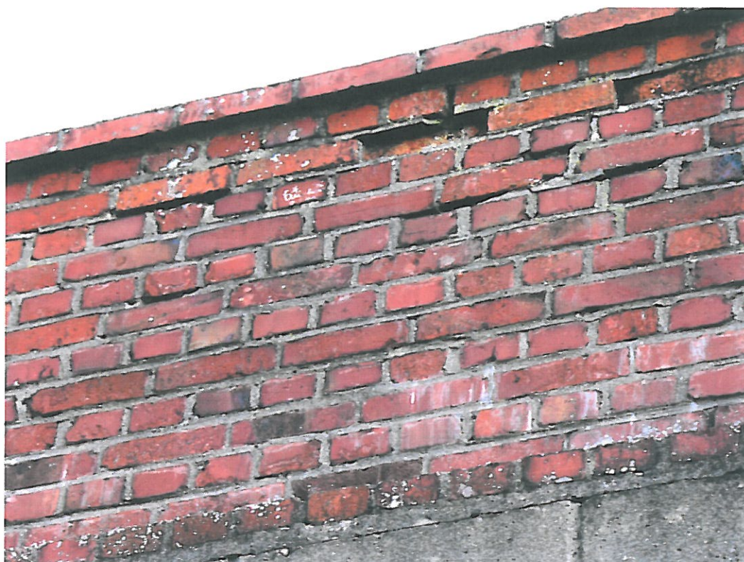
Fot. nr 14 – Ubytki tynku i pęknięcia na konstrukcji sklepienia.
