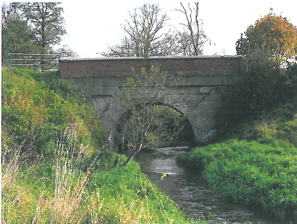
Fot. nr 2 – Widok na obiekt od strony dolnej wody
