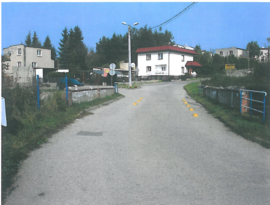
Fot. nr 1 – Widok na obiekt od strony południowo wschodniej
