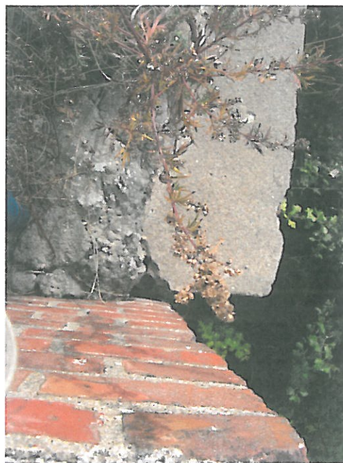
Fot. 2.6 i 2.7 przemieszczenie skrzydeł – od strony dolnej wody
