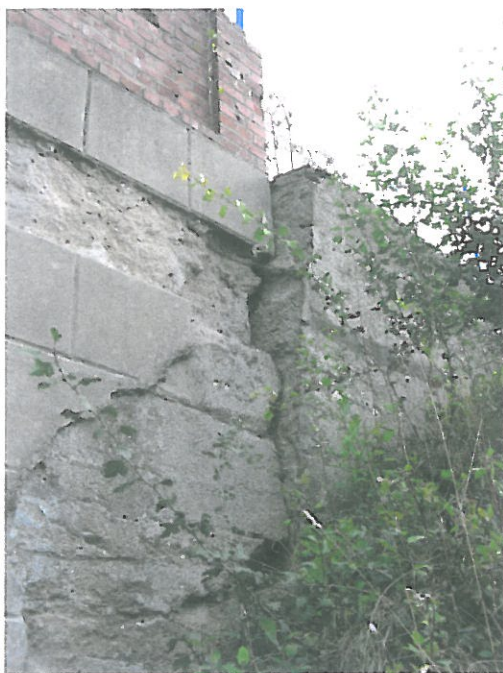
Fot. 2.6 i 2.7 przemieszczenie skrzydeł – od strony dolnej wody
