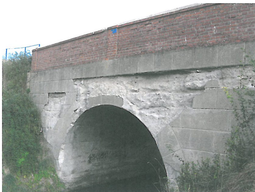
Fot. 1.2 widok mostu od strony dolnej wody
