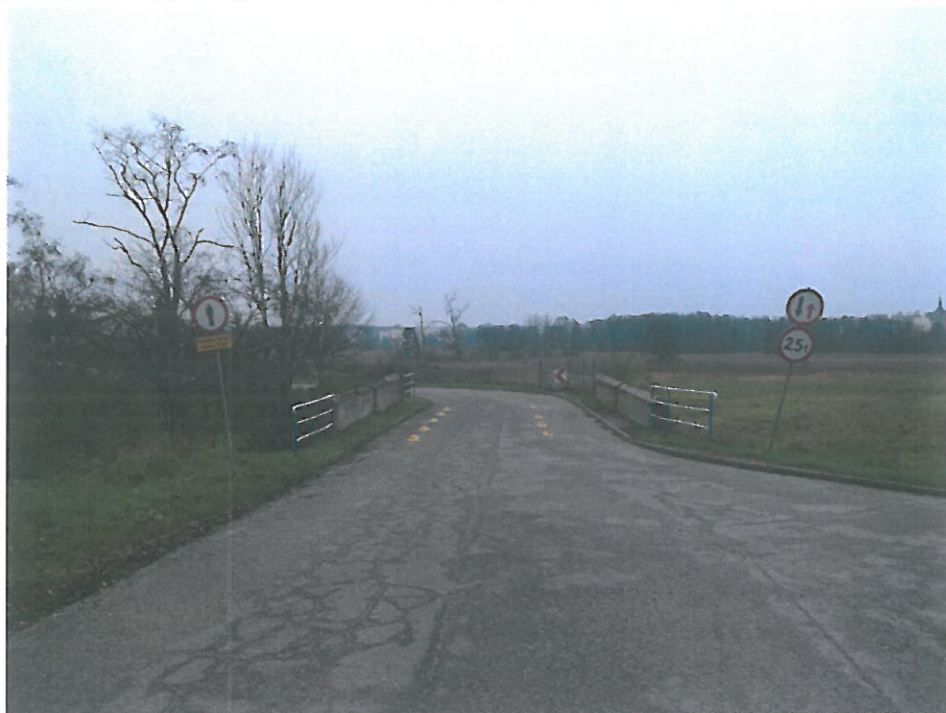
Fot. 3. Dojazd do mostu – widok w kierunku południowym
