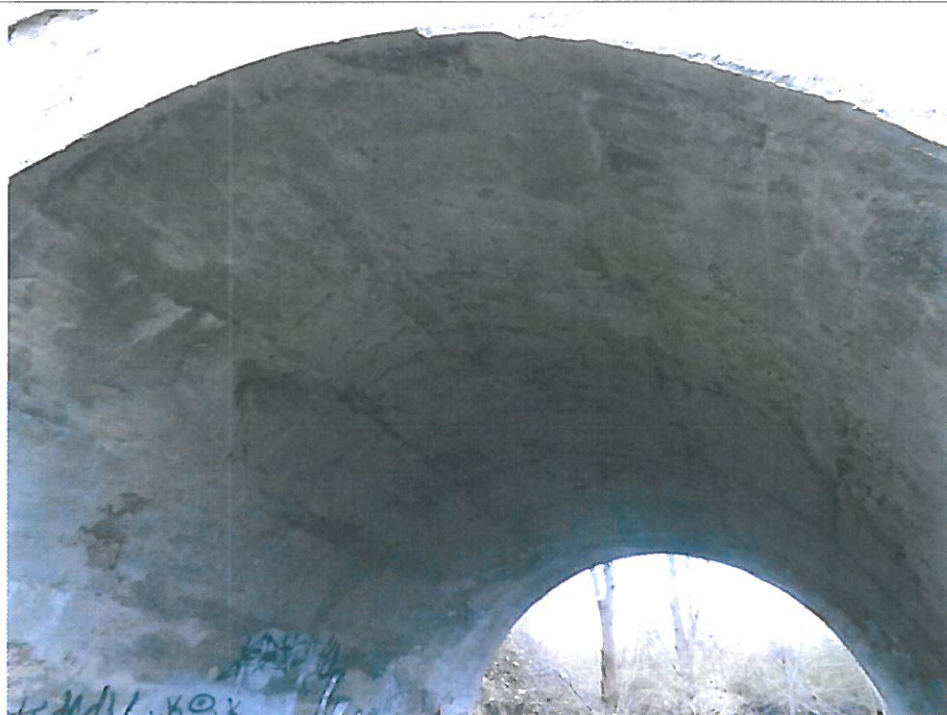
Fot. 6. Widok spodu konstrukcji nośnej (sklepienia)
