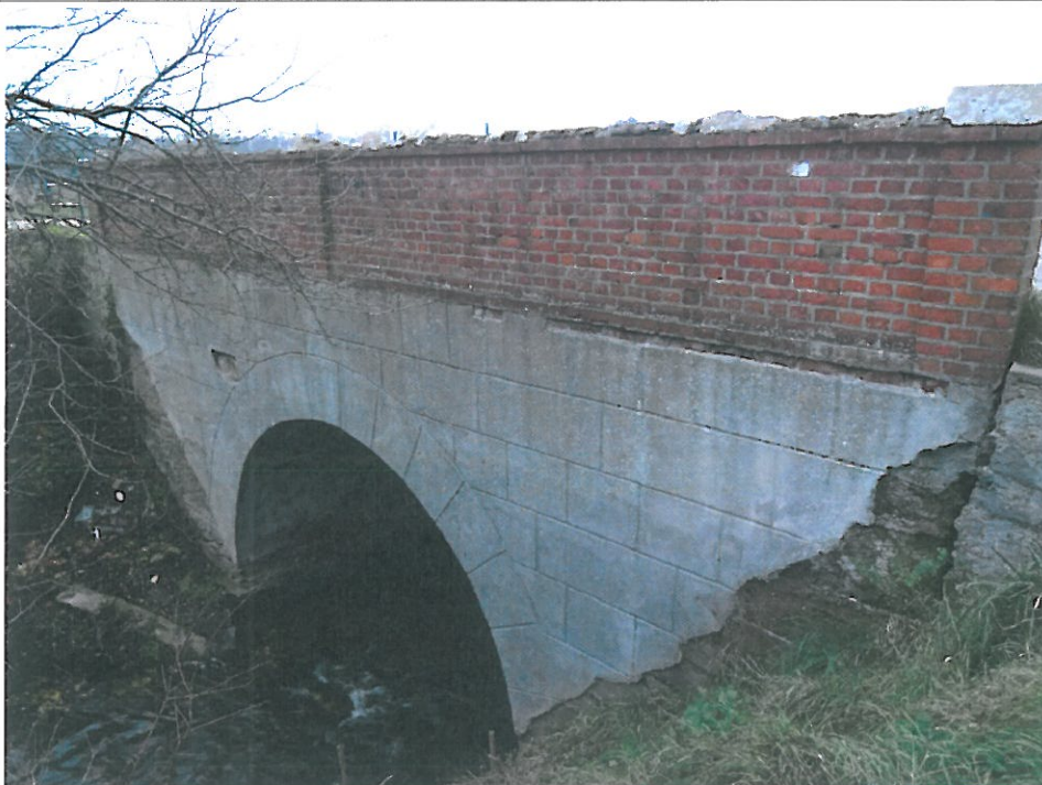
Fot. 2. Widok mostu od strony wschodniej
