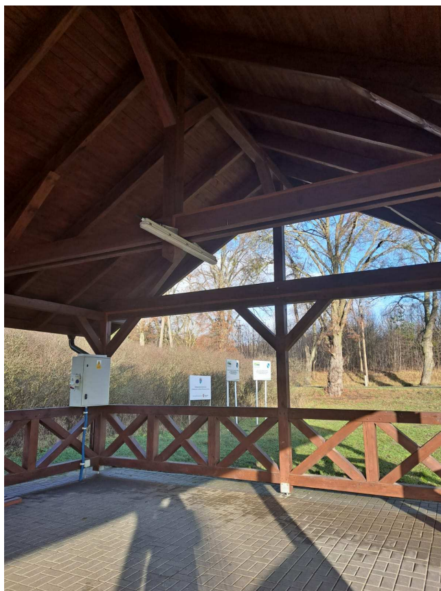
Fot.1 Widok na miejsce planowej przebudowy
