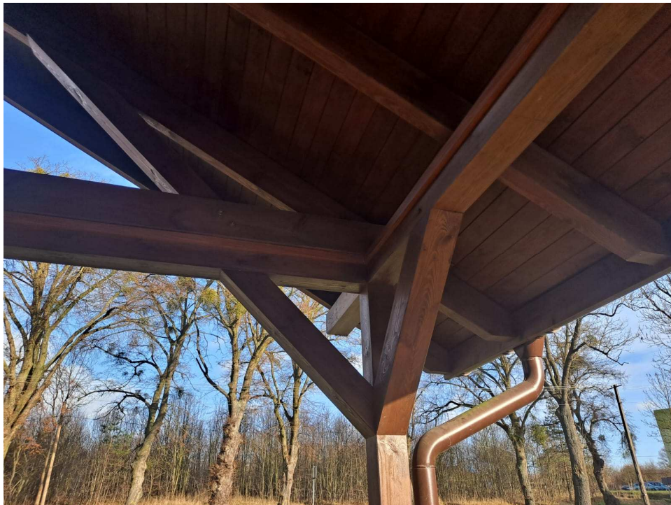
Fot.3. Fragment konstrukcji dachu w miejscu planowanej przebudowy
