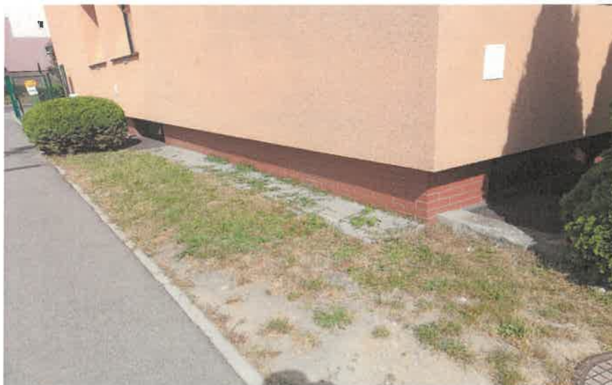
Rysunek 1a WIDOK NA ŚCIANĘ WYJŚCIA-PRZEJŚCIA RUROCIĄGU Z BUDYNKU SZKOŁY – miejsce montażu rozdziału zasilania
