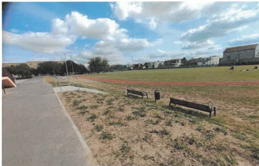
Rysunek 2d WIDOK NA PLANOWANY OBSZAR PRZEJŚCIA RUROCIĄGU I ZASILANIA ELEKTROZAWORÓW PRZES SKARPĘ
