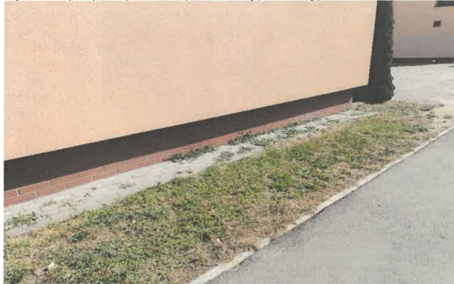
Rysunek 2 WIDOK NA ŚCIANĘ WYJŚCIA-PRZEJŚCIA RUROCIĄGU Z BUDYNKU SZKOŁY
