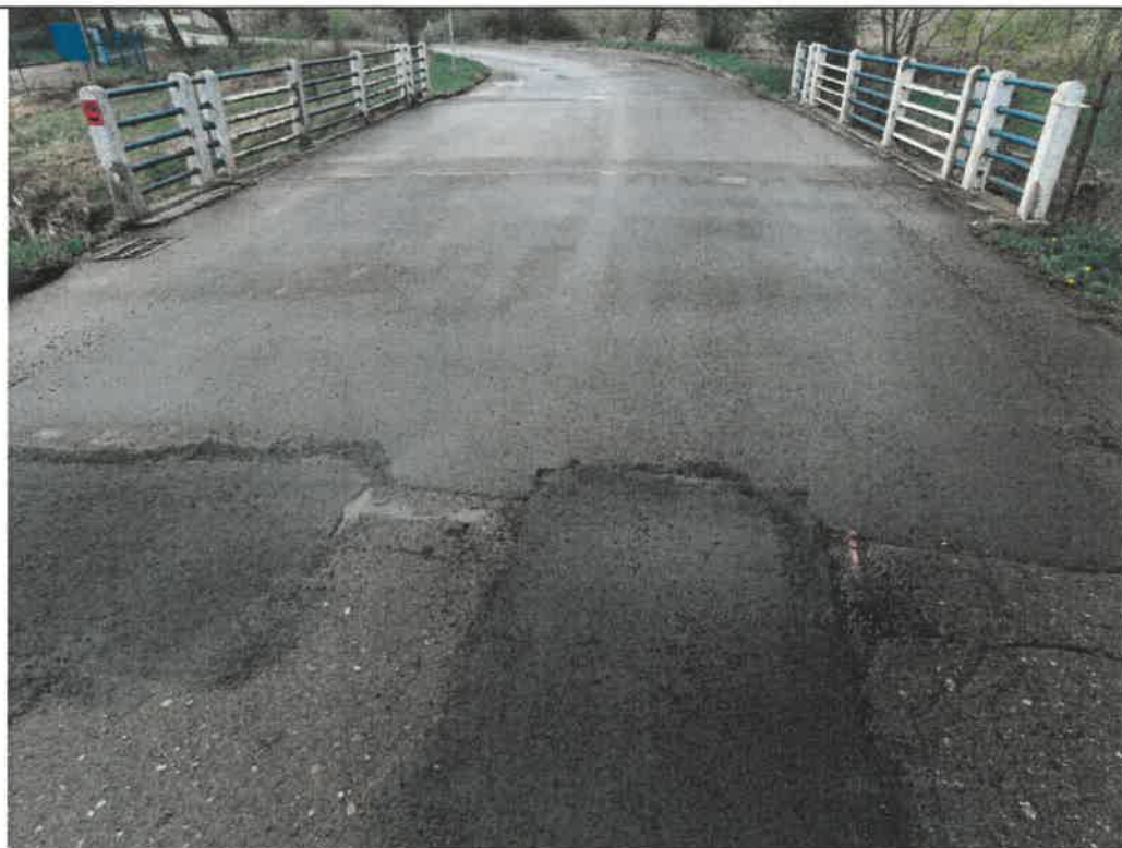
Fot. 4 Brak barier zanikających na dojazdach do obiektu
